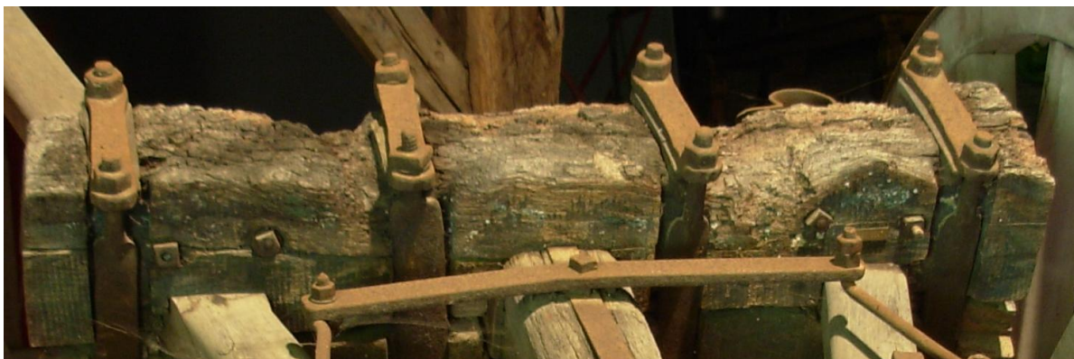
Links: Asblok met duidelijk het hart aanwezig in het hout. (inv. 25) Rechts: Het hart is hier merkbaar in de koppen van de dissel en de rechter schoor. (inv. 27)
