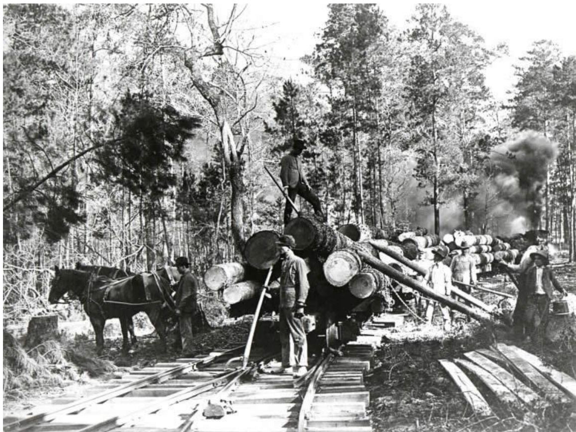
Foto: "Cross loading" van een spoorwegwagon met twee laadbomen in Texas. De voorste man heeft een "peavey", een Amerikaanse variant van de kantelhaak, in 1858 ontworpen door de smid Joseph Peavey te Stillwater. Foto Internet.
