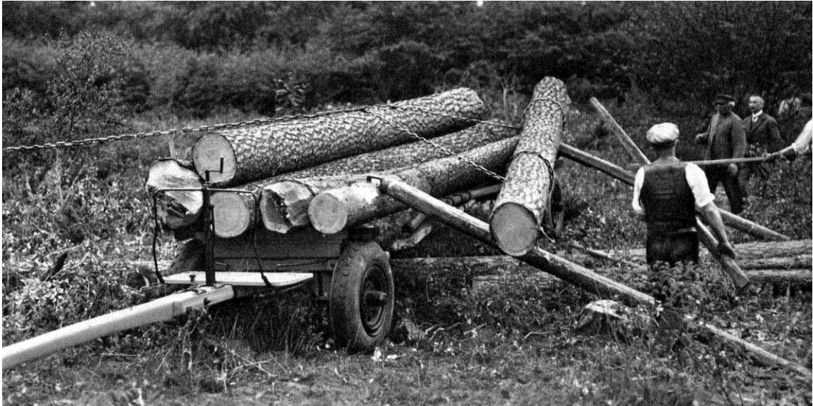
Foto: Een "Graupmann-Langholzwagen". Wagenmaker en houtzager Hermann Graupmann bouwde vanaf 1922 oude auto-chassis om tot platte wagens voor houttransport. Op deze foto wordt het hout rechtstreeks, schuivend, getrokken over de laadbomen. ("Achse, Rad und Wagen" Wilhelm Treue. F. Bruckmann Verlag München, 1965)
