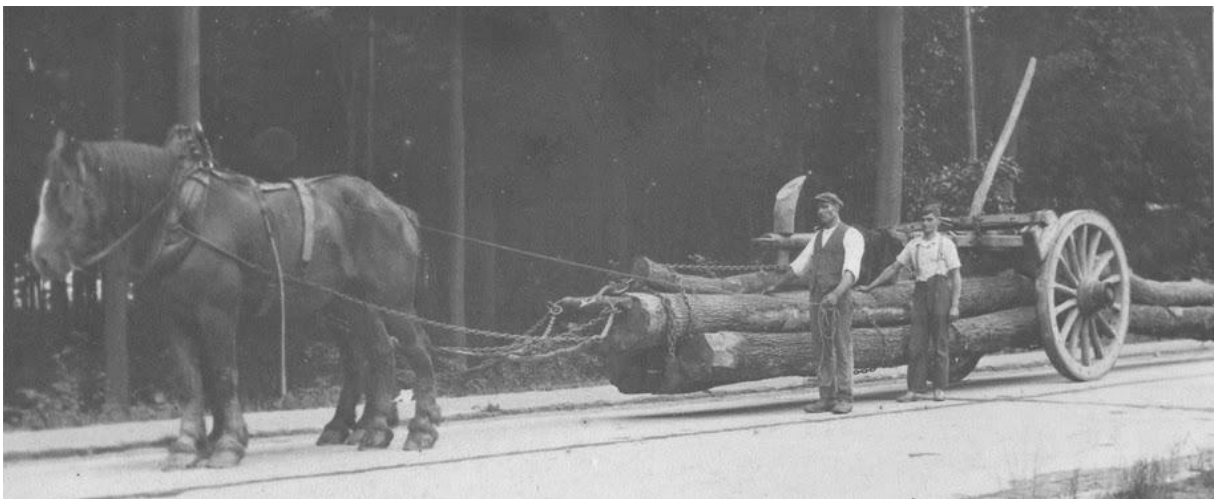
De "oets" met 14 spaken van houtzagerij Vanautgaerdens uit Blanden, waarmee in het Meerdalwoud en het Heverleebos gewerkt werd. Let op de rebalk vóór de wielen! De ongebruikte sleepvoet wordt omgedraaid meegevoerd en is blijkbaar uit een stammetje of een tak gemaakt. Het laadhout staat hier rechts achter. Foto: internet.
