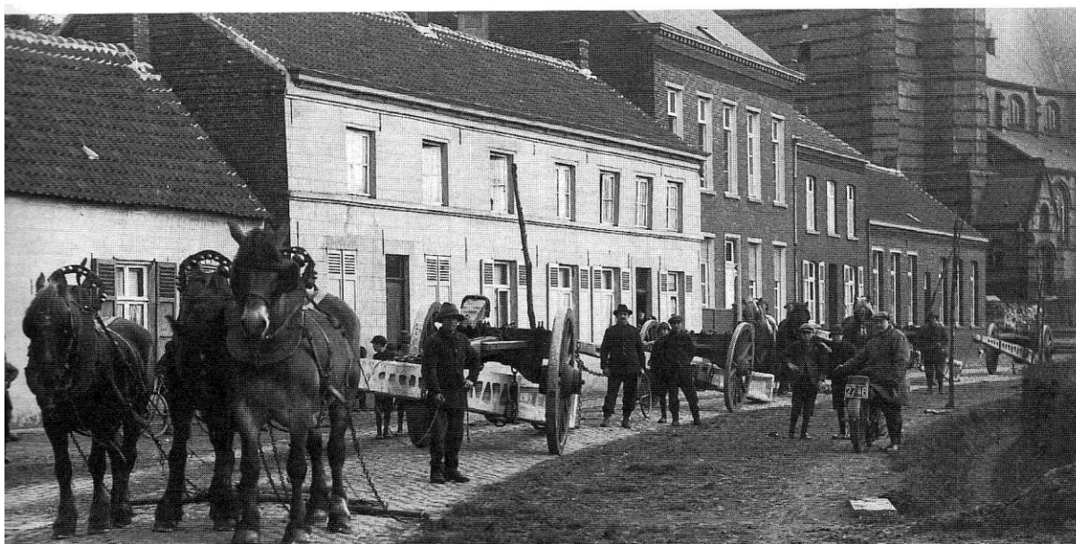
Transport van betonnen electriciteitspalen te Weelde. De eerste boomezel heeft schijnbaar zowel een scharnierend ballastlaadhout met ijzeren verzwaring zoals bij West-Vlaamse exemplaren, als een rechtopstaand laadhout in één of twee beugels links achter. Fotograaf onbekend.
