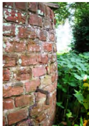
Een duim in de putwand van een waterput in Zemst om de putstok beneden te houden. (Foto Mot.)
