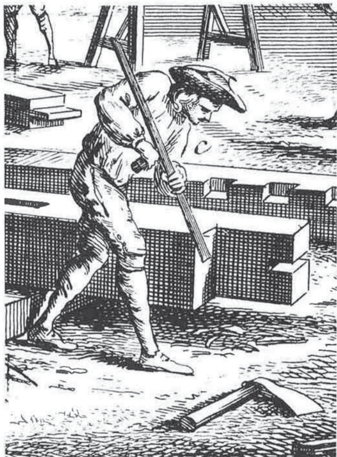
Fig. 7. Bisaiguë. Encyclopédie : charpentier : 1c.
