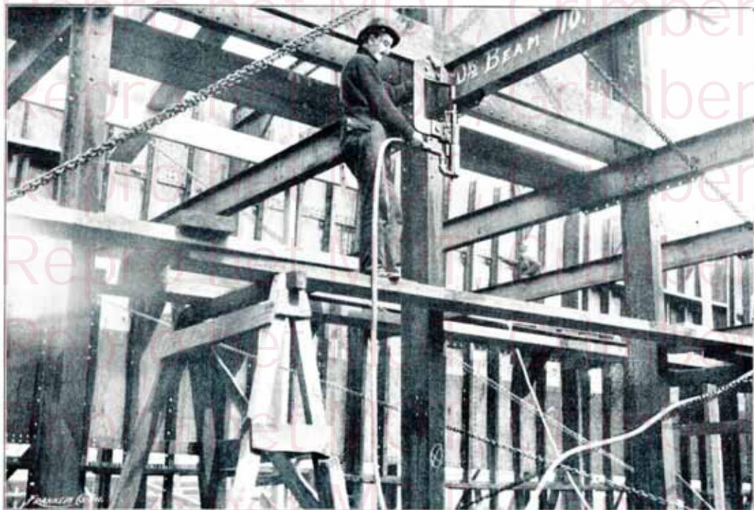
La gravure ci-dessus montre l'application de la riveuse ordinaire dans les constructions navales.
