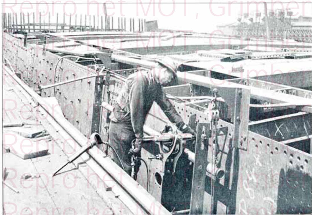
La gravure ci-dessus montre une autre application de la riveuse pour rivets à tête fraisée dans les constructions navales.
