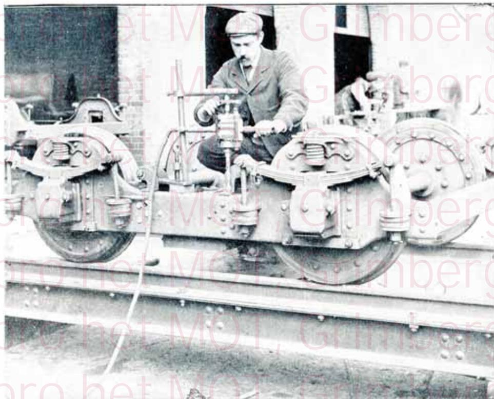
La gravure ci-dessus montre une application de la perceuse pneumatique dans la construction de wagons.
