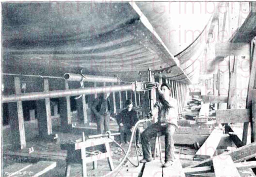
La gravure ci-dessus représente l'application de la riveuse pour rivets à tête fraisée dans les constructions navales. (Travail de la coque.)
