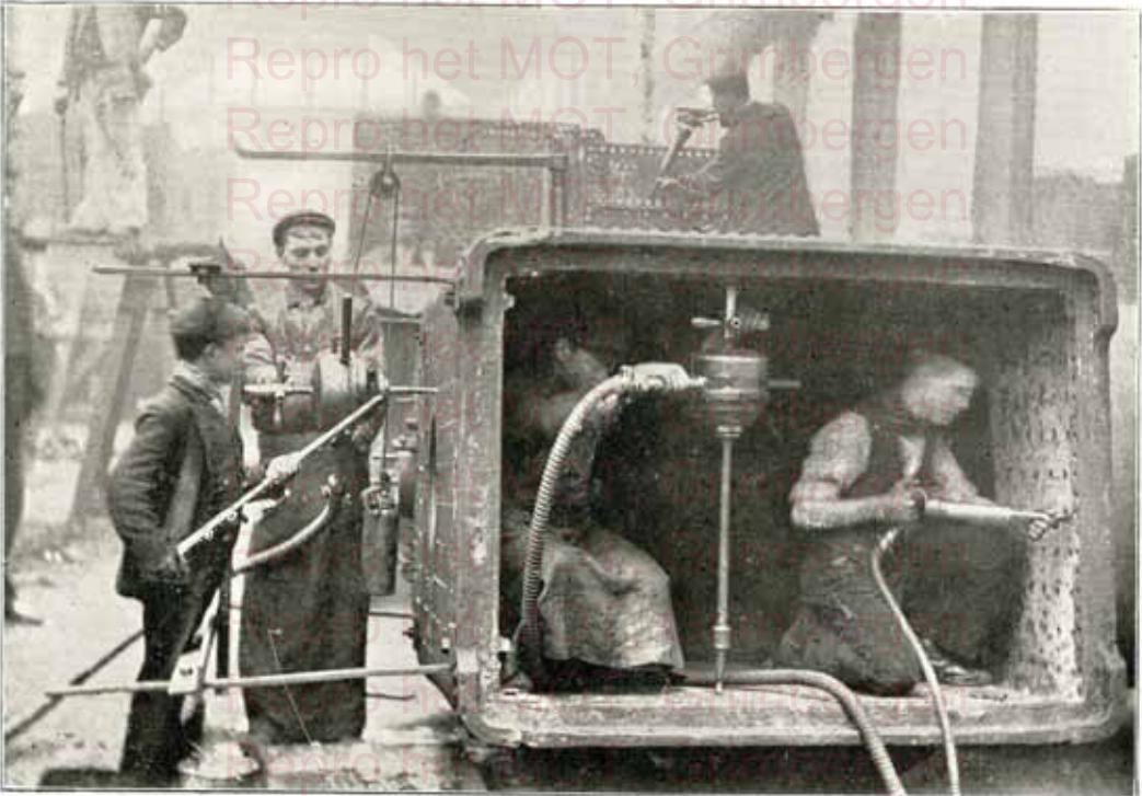
Réparation d'une boîte à feu au moyen de la foreuse "BOYER" et du marteau à détartrer.
