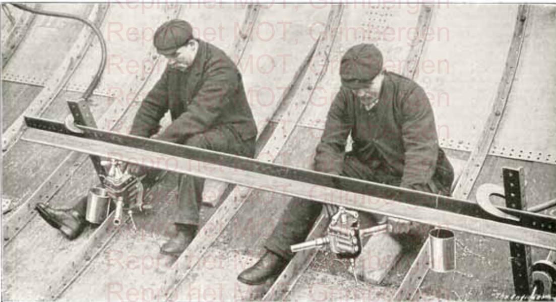
Foreuses "PETIT GEANT" utilisées dans la construction de navires pour le perçage des tôles de fond après mise en place, en utilisant les tôles intérieures comme gabarits de perçage.
