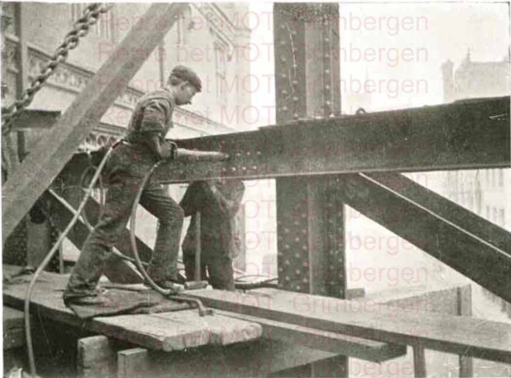
Application du marteau à rivet "BOYER" dans la construction de ponts métalliques.
