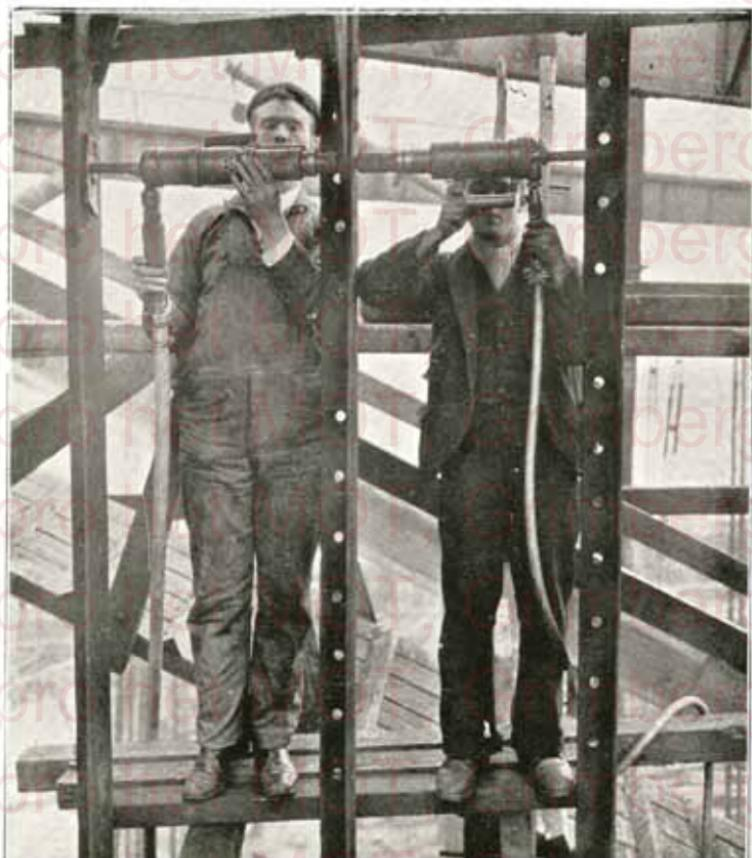
Application de la rivuse "BOYER" No. 000 sans bâti, mais avec tas pneumatique, dans le rivetage de charpentes métalliques de navires.
