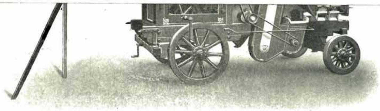
**Motobatteuse n° 3 a** avec moteur de 5 H P. — Débit 60 sacs. L'idéal pour l'entrepreneur de battages, 1 m. 80 de largeur intérieure, double nettoyage et ébarbeur réglable, réservoir à eau soudé au chalumeau oxydrique, fortes roues en bois ou en fer avec frein.
