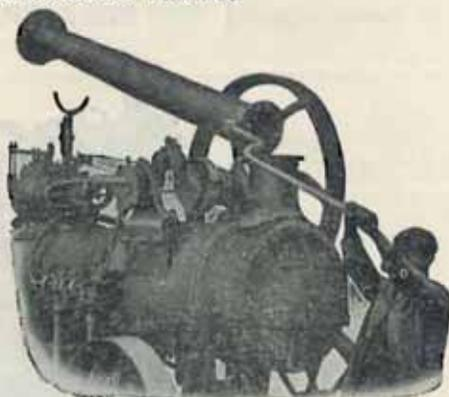
**Chaudière type locomotive, à haute pression, 9 atmosphères, à 1 cylindre**
