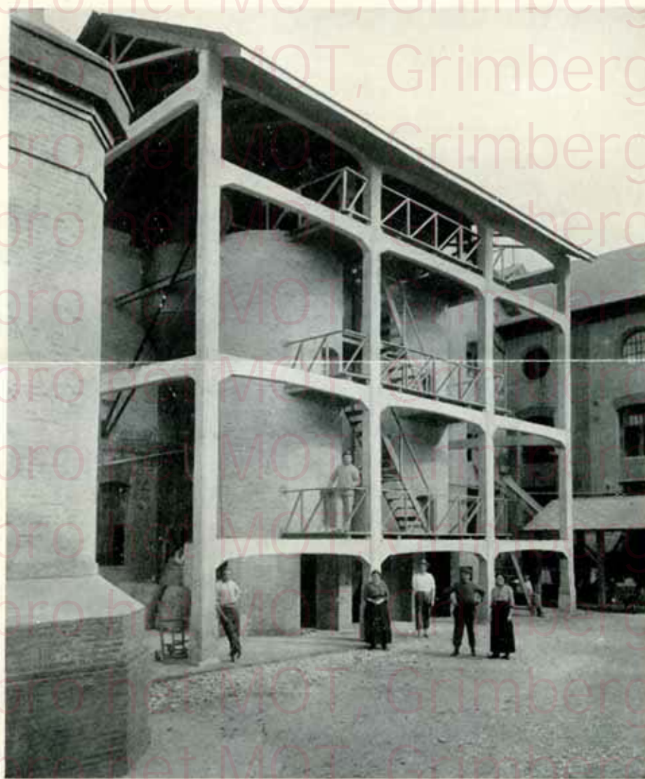
Vue d'ensemble d'une installation de séchage de pulpes système "HUILLARD"
