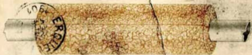
Repro het MOT, Grimbergen Repro het MOT, Grimbergen Coquilles calorifuges posées Repro het MOT, Grimbergen
