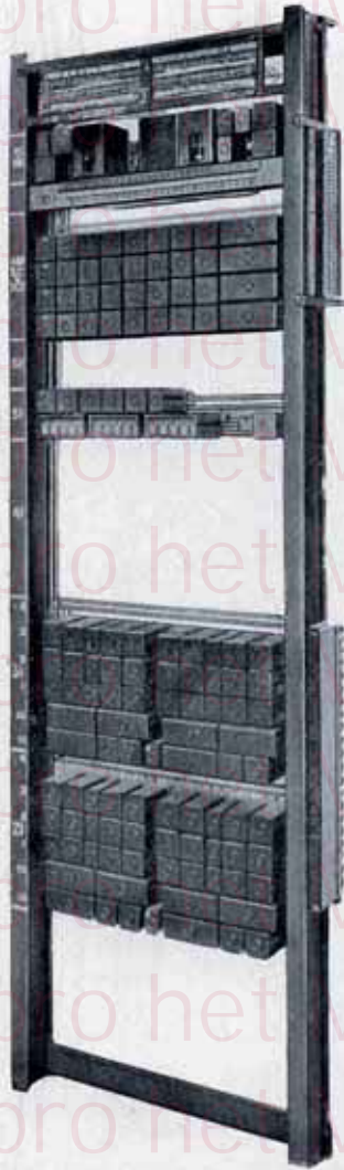
Fig. 8. — Installation automatique à relais (50 lignes, dont 20 équipées).
