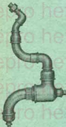
Das aus Fittings von  $\frac{1}{2}$ " bis 2" bestehende Versuchsstück wurde mit Wasser gefüllt und an eine Hochdruckleitung angeschlossen und der Innendruck allmählich gesteigert.
