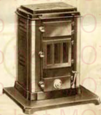
FOYER HYGIÉNIQUE N° 492 capacité de chauffe : 175 m. c.
