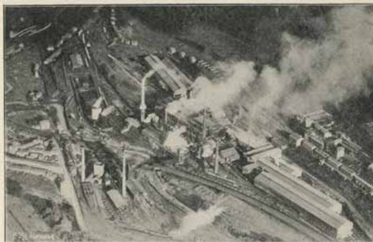
Vue des usines de Longwy-Bas.
