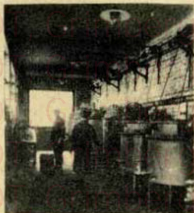
Autoclaven Groep voor de fabricatie van den schoencreem.
