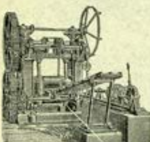
Cages et Trains de Laminaires Martres-Pilons, Élévateurs Appareils pour réchauffer l'air.
