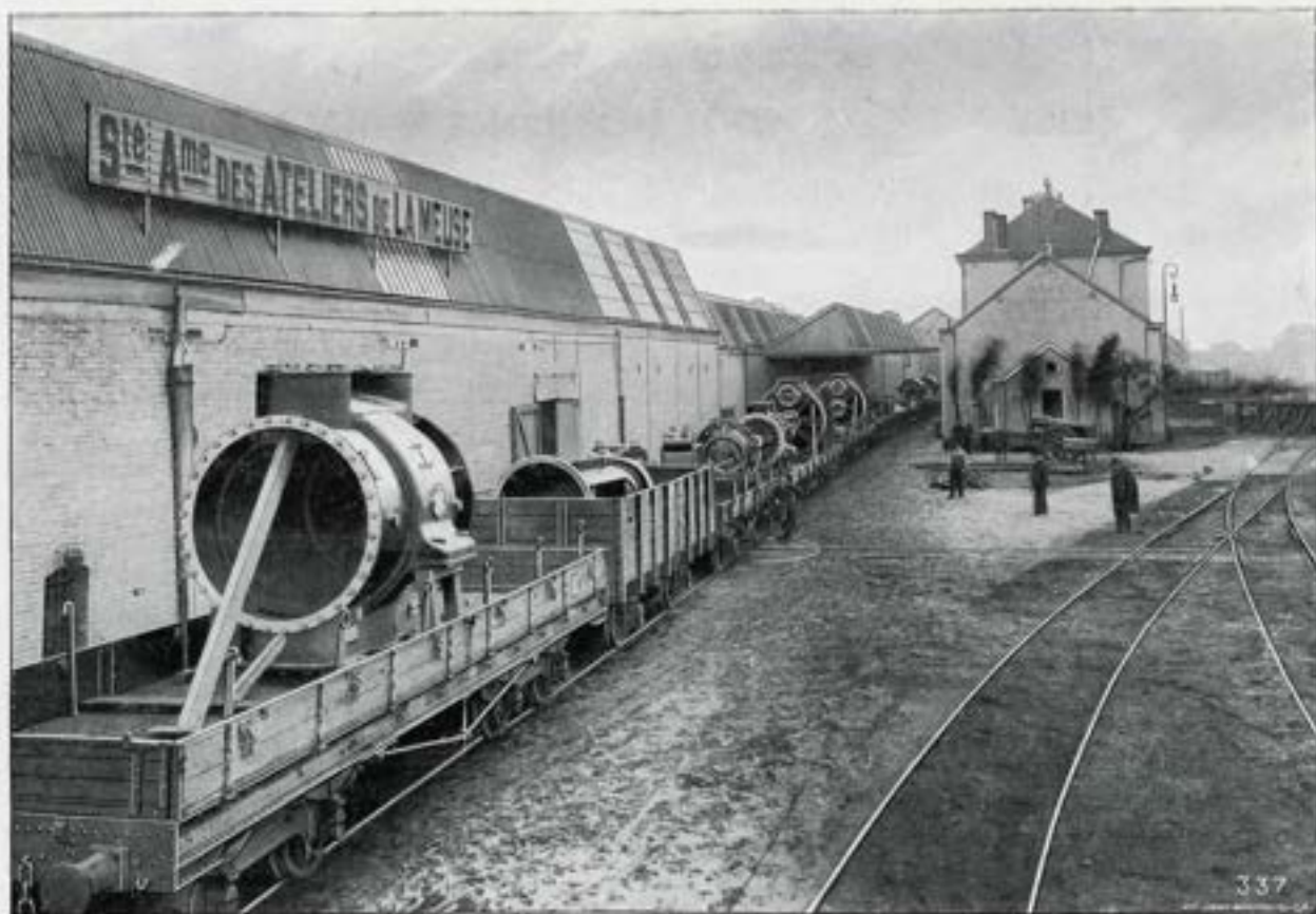
Gare privée de l'usine
