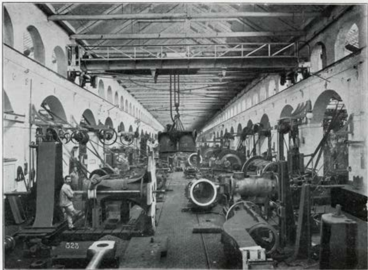
Nef centrale de l'atelier des machines-outils
