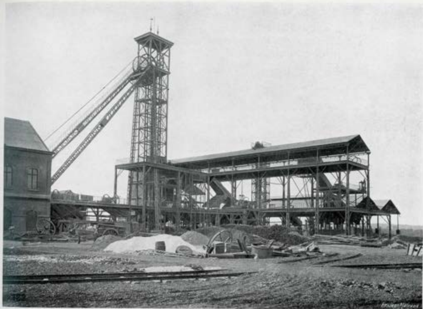
Chevalement à Molettes avec Ponts et Trémies de chargement
