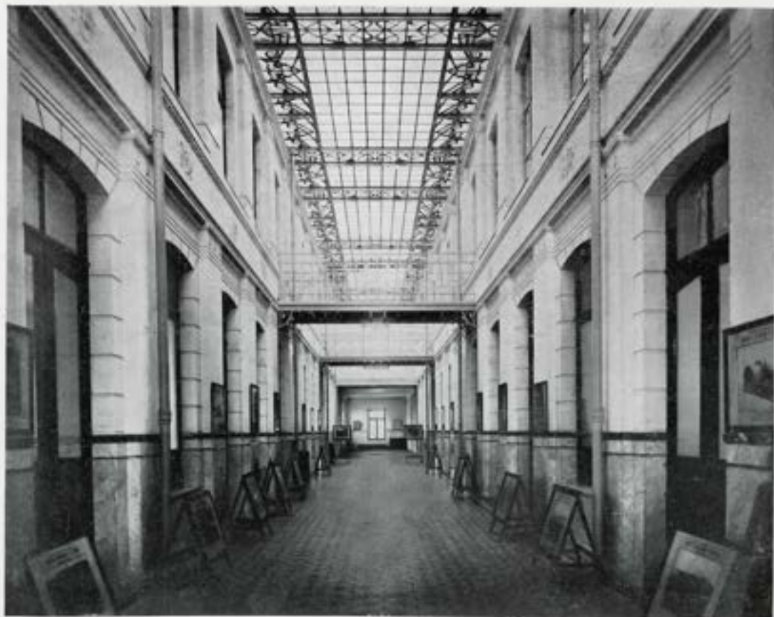
Entrée des Bureaux d'administration
