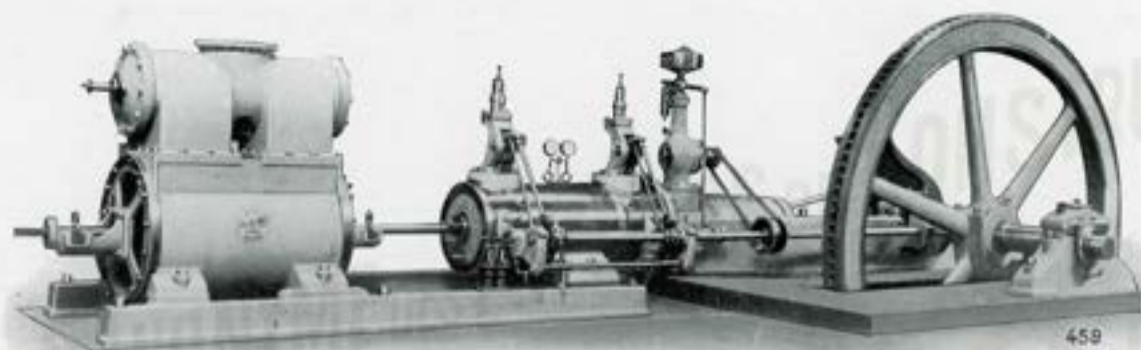
MACHINE SOUFFLANTE MONOCYLINDRIQUE pour petits convertisseurs.
