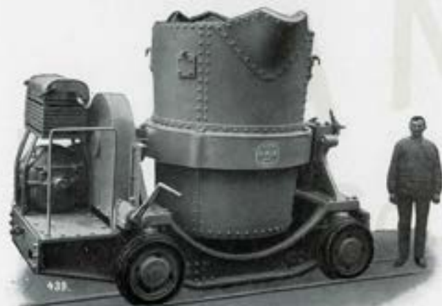
POCHES A FONTE montées sur chariots, avec commandes électriques ou à main.
