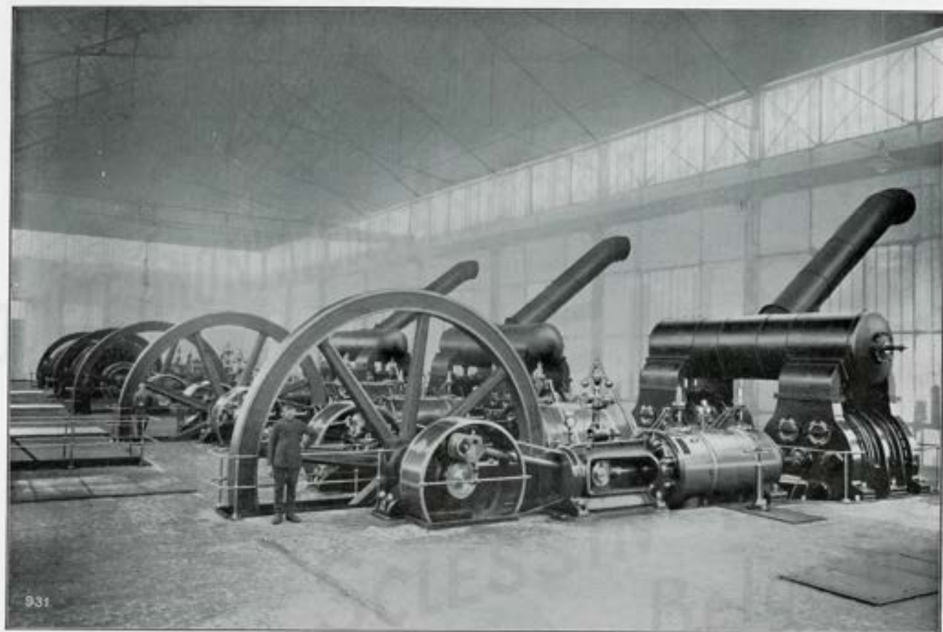
GROUPE DE MACHINES SOUFFLANTES DE HAUTS-FOURNEAUX construites par la Société de LA MEUSE.
