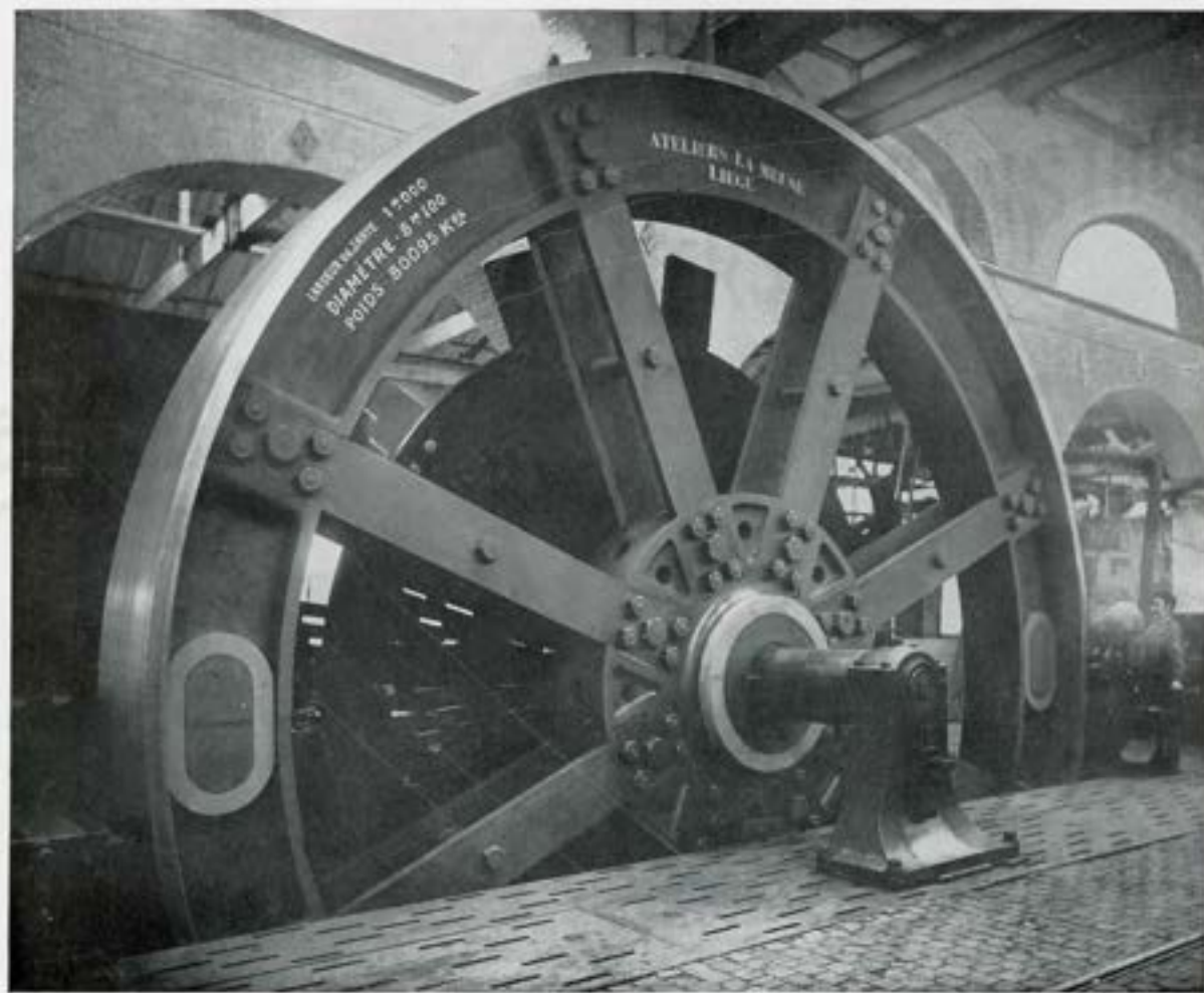
VOLANT DE LAMINOIR DE 80 TONNES.
