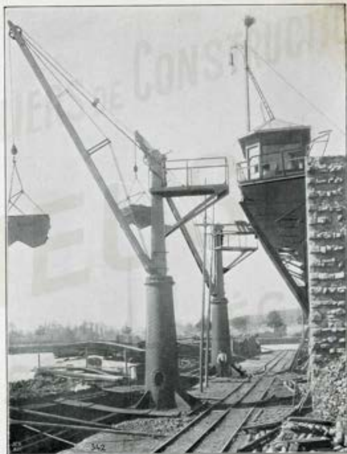
GRUES HYDRAULIQUES, FIXES, installées aux USINES MÉTALLURGIQUES DE NEUVES-MAISONS (FRANCE)
