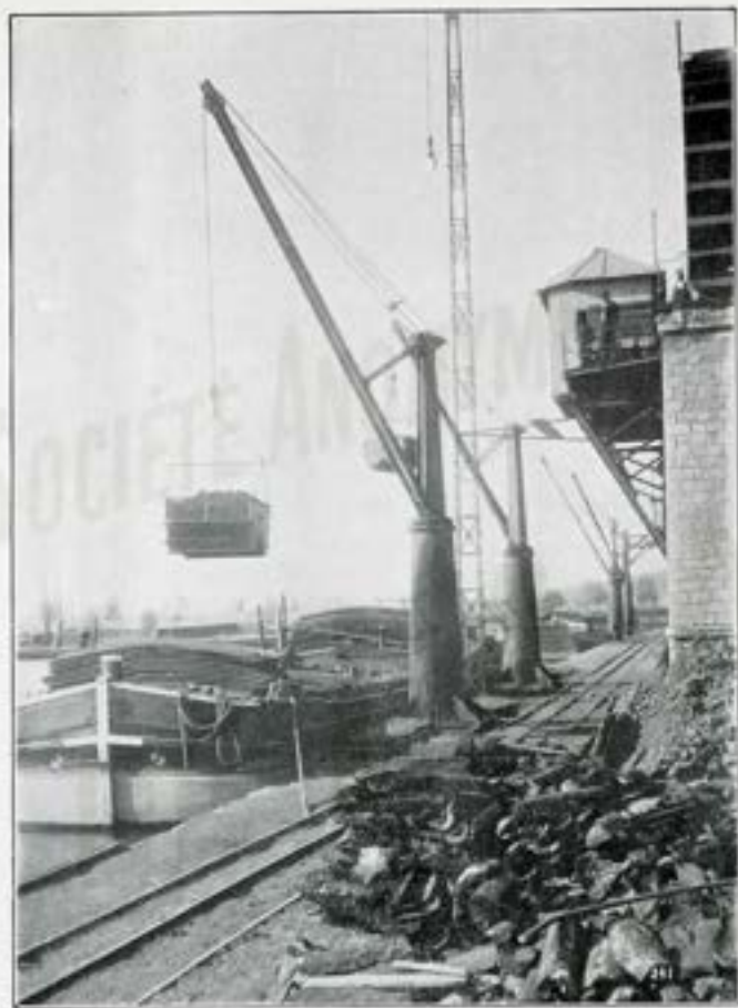
GRUES HYDRAULIQUES, FIXES, installées aux USINES MÉTALLURGIQUES DE NEUVES-MAISONS (FRANCE)
