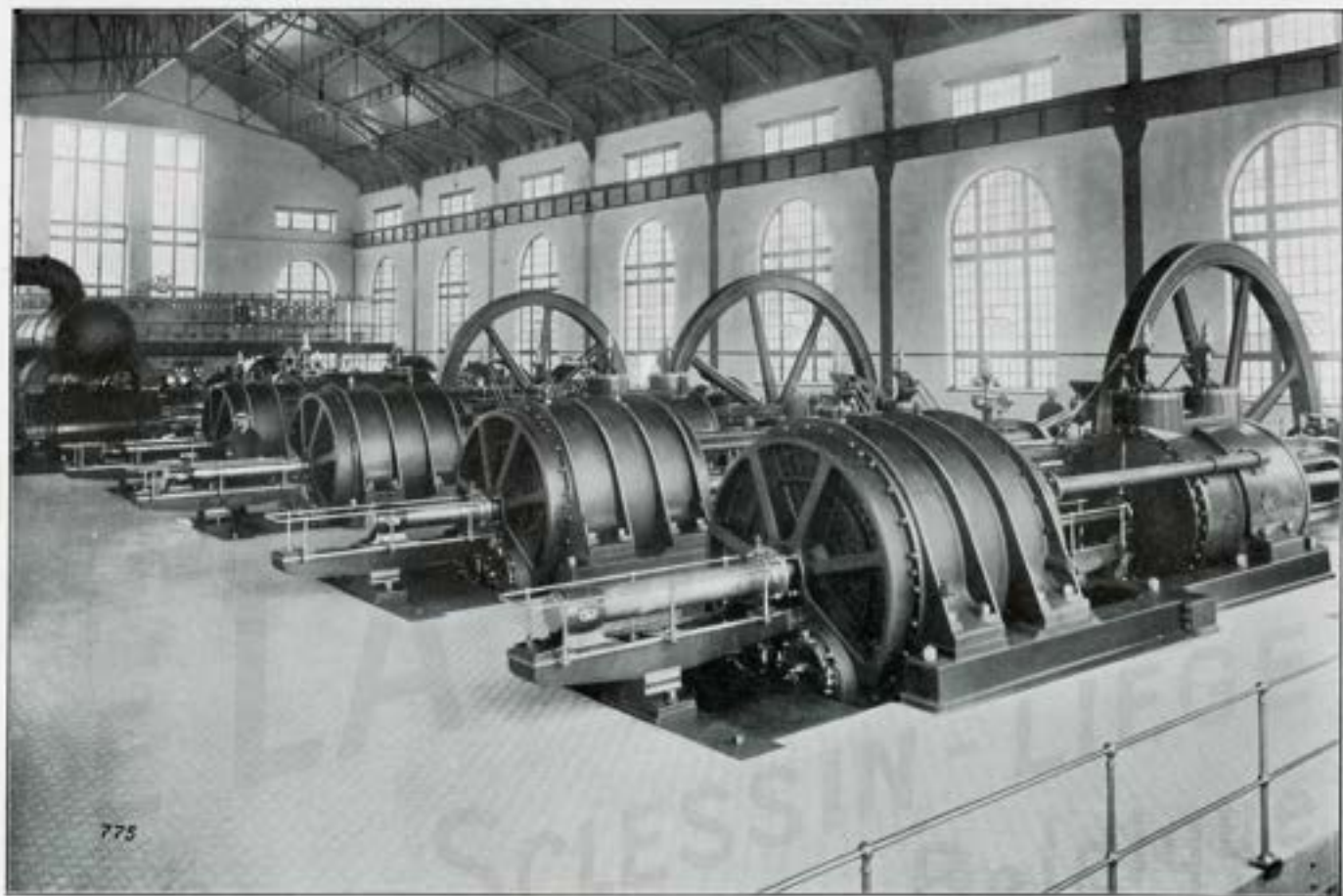
GROUPE DE MACHINES SOUFFLANTES DE HAUTS-FOURNEAUX ET D'ACIÉRIE construites par la Société de LA MEUSE.
