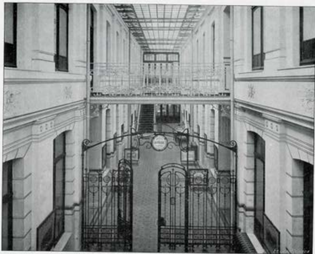
Entrée des Bureaux d'Administration.
