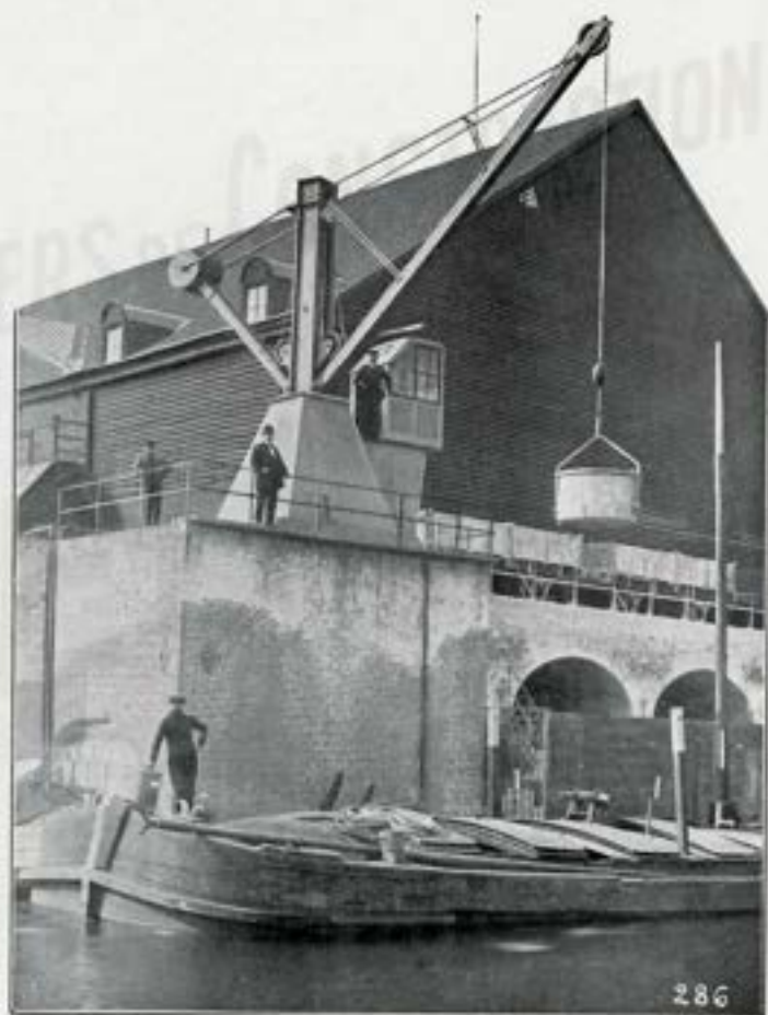
GRUE HYDRAULIQUE fixe pour rivage.
