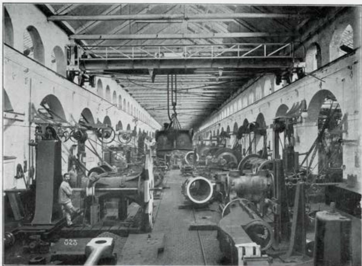
Nef centrale de l'atelier des machines-outils.
