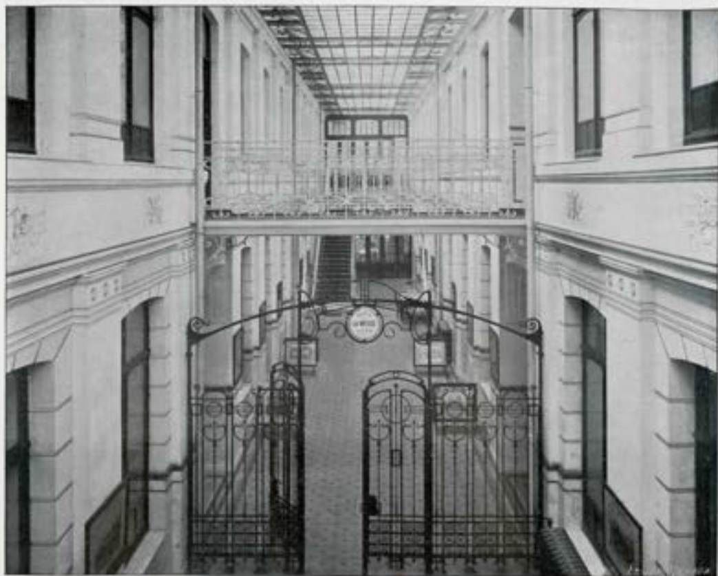
Entrée des bureaux d'administration.
