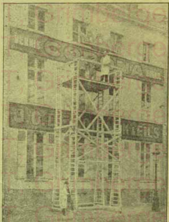
Echafaudage volant monté sur roues. Combinaison de quatre échelles à transformation. Vliegende stelling gemonteerd op wielen. Aaneenschakeling van vier veranderbare ladders.
