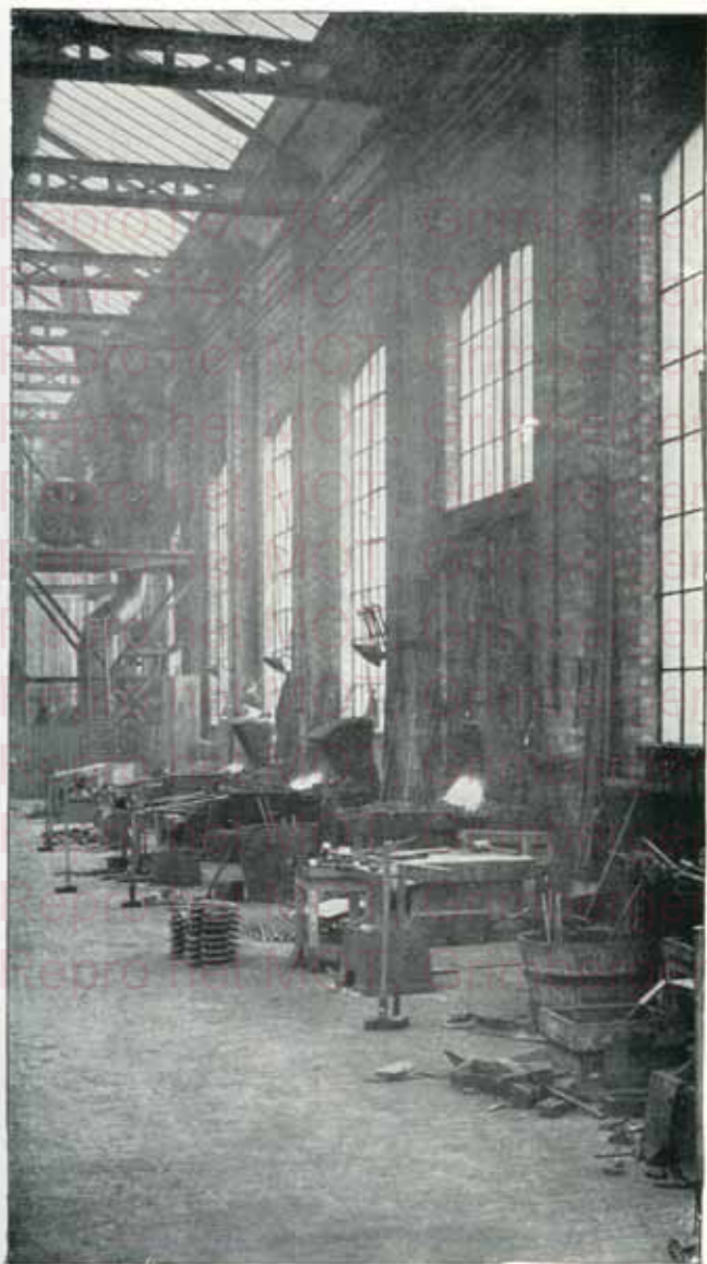
Installation de Forges Sturtevant avec tuyauterie souterraine et hottes réglables à tirage renversé.
