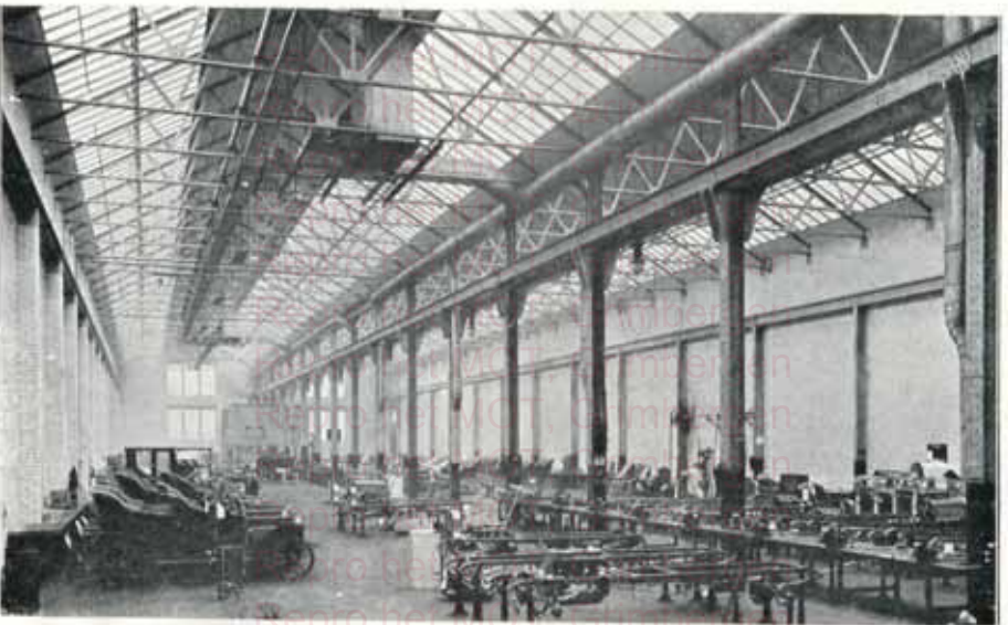
Intérieur d'un atelier de construction d'automobiles, montrant les conduites aériennes pour la distribution de l'air chaud en hiver et de l'air frais en été.
