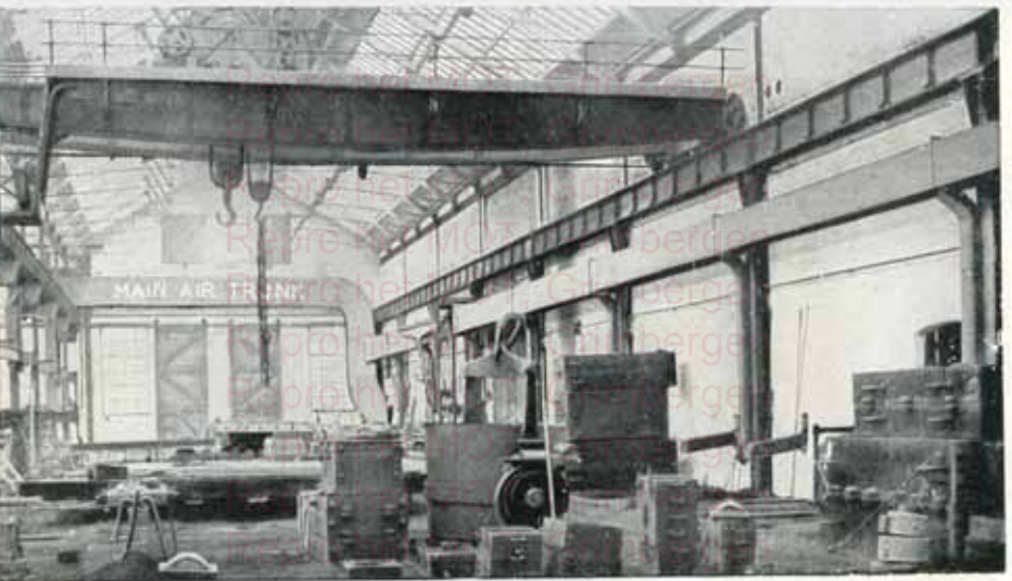
Vue d'une Fonderie Moderne montrant la tuyauterie distribuant l'air chaud en hiver et l'air frais en été.
