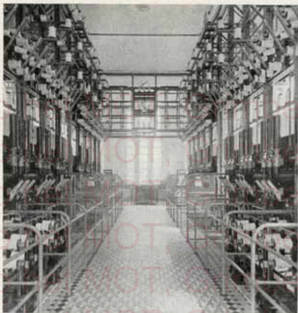
Electricité de la Province du Limbourg. Sous-station de Godscheid à 10 KV.
