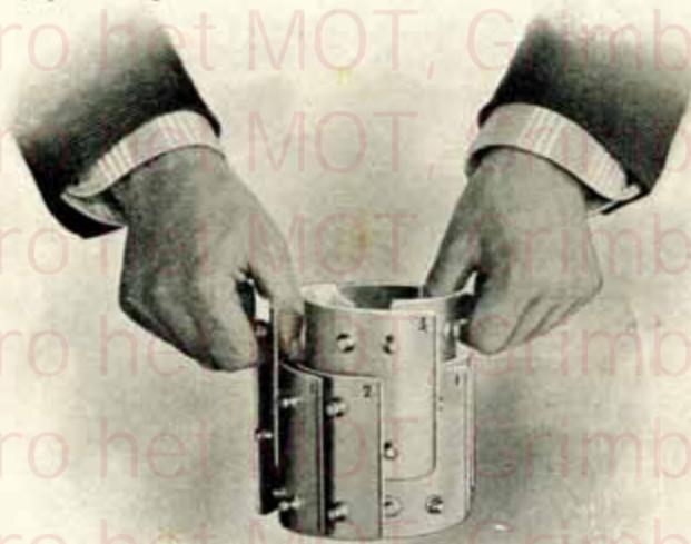
Enfin lorsqu'il y a trois pièces, placez le jeu retiré du bol sur une table; puis, comme l'indique la fig. ci-contre, soulevez la pièce n° 3 avec les index appuyés sur les butées n° 3, tandis que les pièces n° 1 et 2 sont maintenues par les pouces. La pièce n° 3 s'enlève ensuite aisément.
