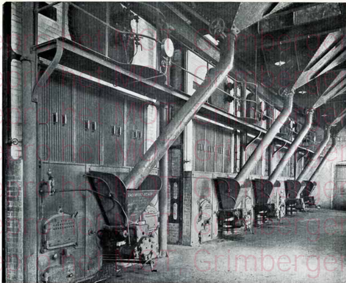
CINQ CHARGEURS « MODÈLE E » APPLIQUÉS A CINQ CHAUDIÈRES MULTITUBULAIRES
