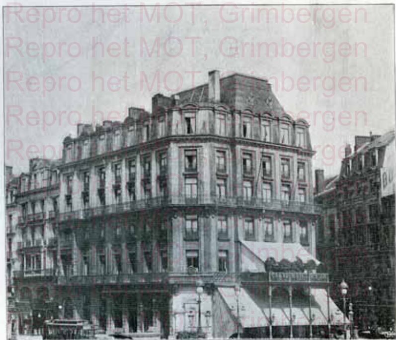
Hôtel Central, Place de la Bourse, Bruxelles.
