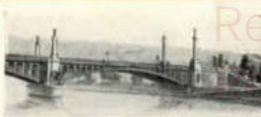
Pont de Fragnée
