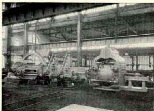
Soufflerie à gaz de 1,500 chevaux
