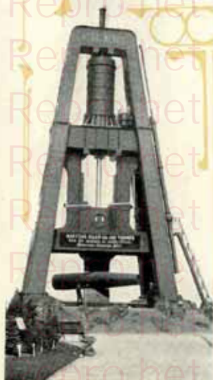
Marteau-pilon de 100 tonnes, de Terni (Italie)
