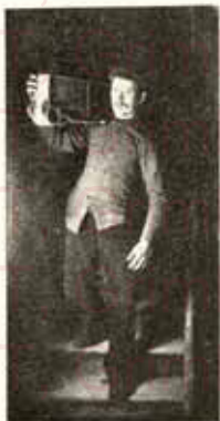
TRANSPORT DE LA CHAUFFIÈRE.
