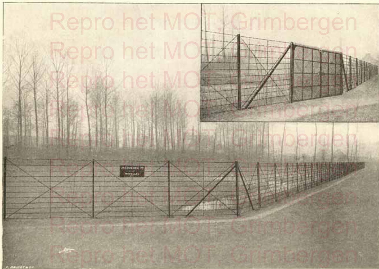
Clôtures brevetées défensives en ronçes artificielles avec croix de St-André, pour chemins de fer, raccordements, usines, propriétés privées, etc.
