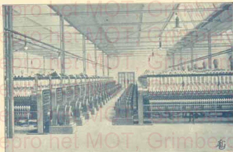
Métiers continus à filer, commande individuelle actionnés par moteurs triphasés avec induit en court-circuit (cas d'accouplement direct).
