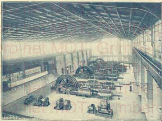
Usine d'Electricité de la Ville de Bruxelles. Trois Alternateurs triphasés de 3500 kilowatts chacun. Un Alternateur triphasé de 2050 kilowatts. — (5000 volts.)
