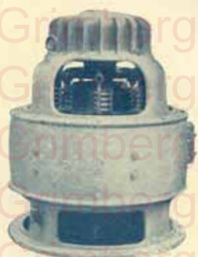
Dynamo à axe vertical pour turbine hydraulique.
