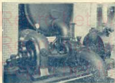
Turbo-Pompe à condensation
