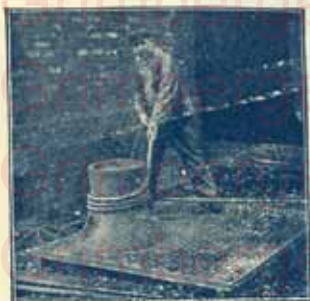
Cabestan électrique en service.
