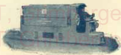
Locomotive de fond, avec accumulateurs.
