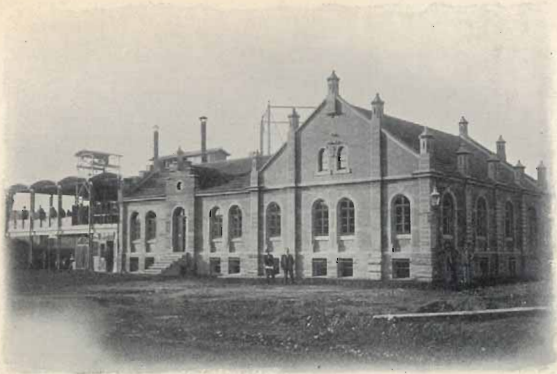
Usine à gaz d'eau, système Dellwik-Fleischer, à Pforzheim. Vue générale.
