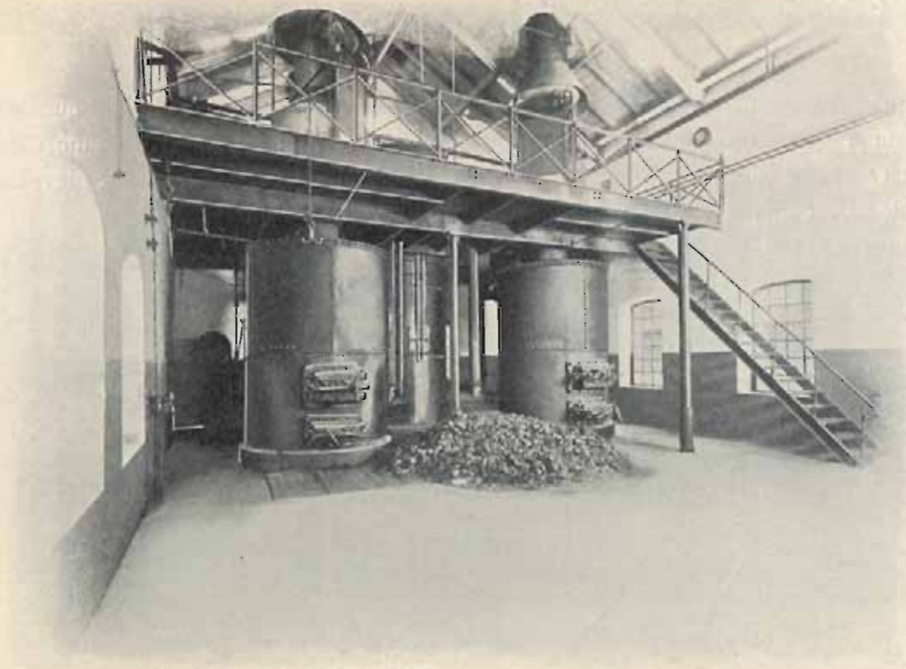
Usine à gaz d'eau, système Dellwik-Fleischer, à Barmen-Rittershausen. Salle des générateurs.
