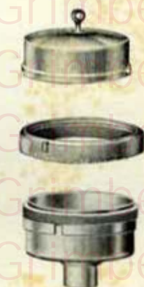
Fig. 6. - Les 3 parties de la turbine.
