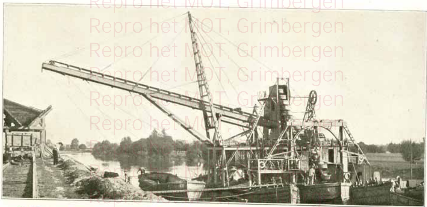
M. Paul Frot, Entrepreneur de Travaux Publics à Meaux, près Paris, a conçu une installation analogue à celle dont nous venons de parler pour l'exécution d'immenses remblais qui permettront l'agrandissement de la gare de Nantes-Etat, sur les bords de la Loire. Le Transporteur a une longueur de 30 mètres avec une pente de 32 cm. par mètre; la courroie d'une capacité de 300 mètres cubes à l'heure, est 81 cm. de large.
