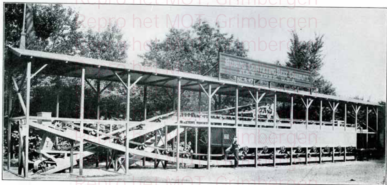
A l'Exposition Universelle de Paris en 1900, la Robins Conveying Belt Company était représentée par six transporteurs en action permanente, dont quatre étaient de grandeur naturelle et deux en modèles. Ces machines ont obtenu le seul Grand Prix qui était réservé aux transporteurs. Nous avons eu l'honneur de recevoir des Ingénieurs de tous pays qui étaient unanimes à reconnaître la simplicité et la puissance du Transporteur Robins.
