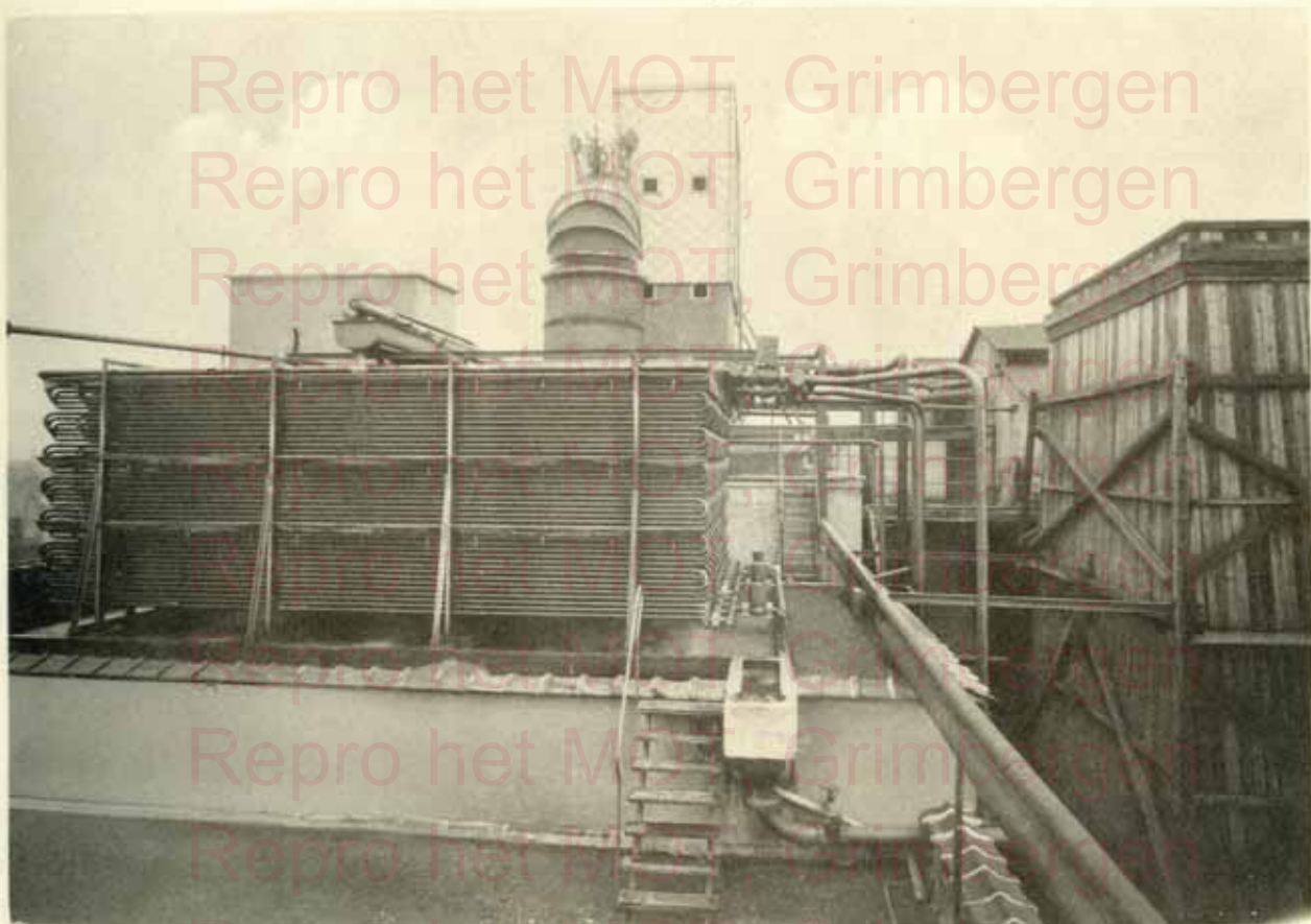
Cabine et condenseurs. Kabinen en verdamper.
