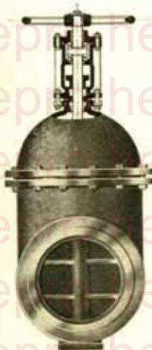
La vanne que nous avons figurée à cette planche a été étudiée pour obtenir une manœuvre facile, cette vanne est usinée spécialement à l'intérieur du corps et les réactions de la tige se font sur double butée à billes.
