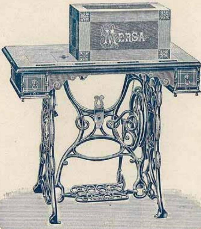
La transformation de la machine en table se fait par un mécanisme pratique qui permet à la main la plus faible de l'exécuter en quelques secondes.
