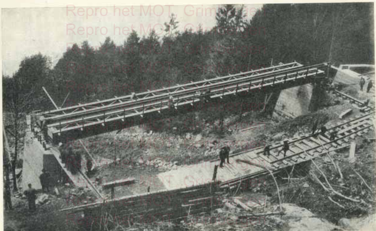
FIG. 8. — Construction d'un pont-route sur l'Axenstrasse (Lac des Quatre-Cantons, Suisse) Quatre poutrelles 100 DIN de 31 mètres de longueur
