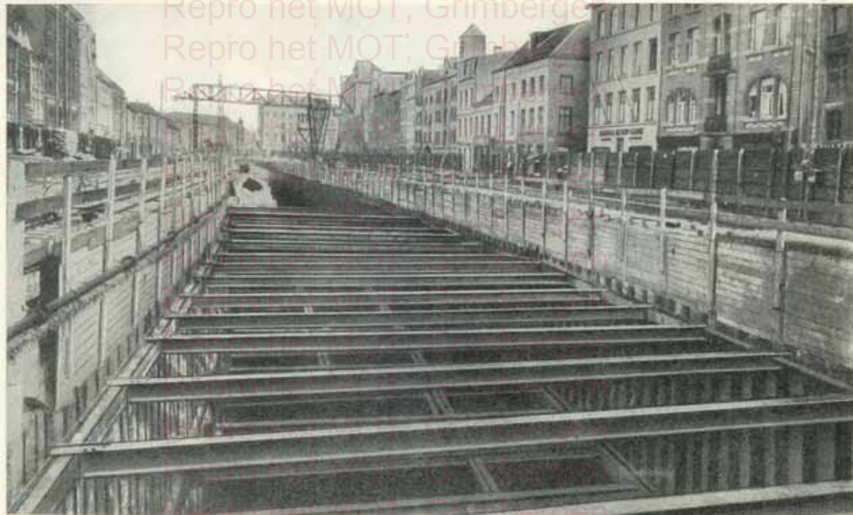
Fig. 17. — Travaux du tunnel sous l'Escaut à Anvers. Etançonnement en poutrelles Grey
