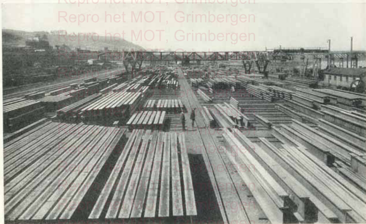
FIG. 3. — Vue générale du parc à poutrelles Grey
