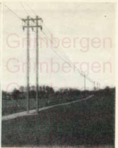
FIG. 22. — Compagnie Grand- Ducale d'Electricité (Luxembourg) Poteau de sectionnement
