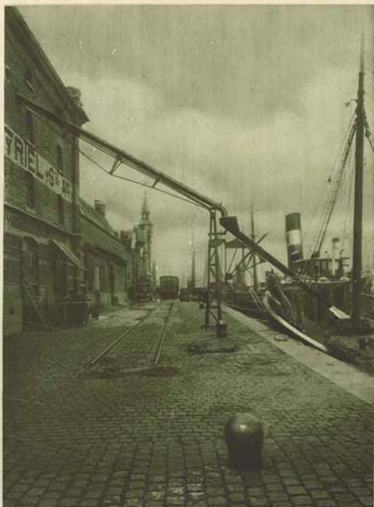
Installation de chargement de glace concassée dans les bateaux de pêche, au moyen d'un élévateur vertical et d'un système de goulotte relevable, tournante et à parties amovibles.
