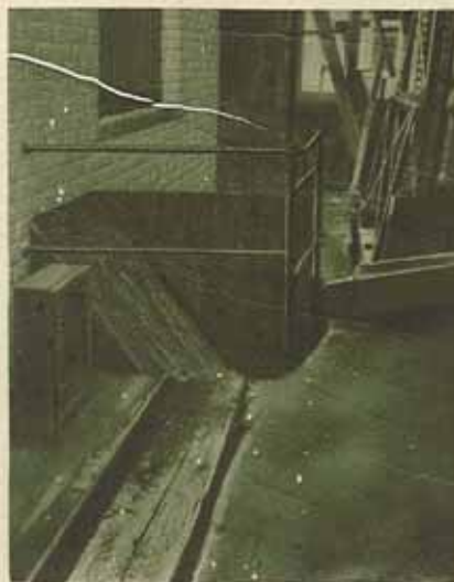
Installation de chargement de glace concassée dans les bateaux de pêche, au moyen d'un élévateur vertical et d'un système de goulotte relevable, tournante et à parties amovibles.
