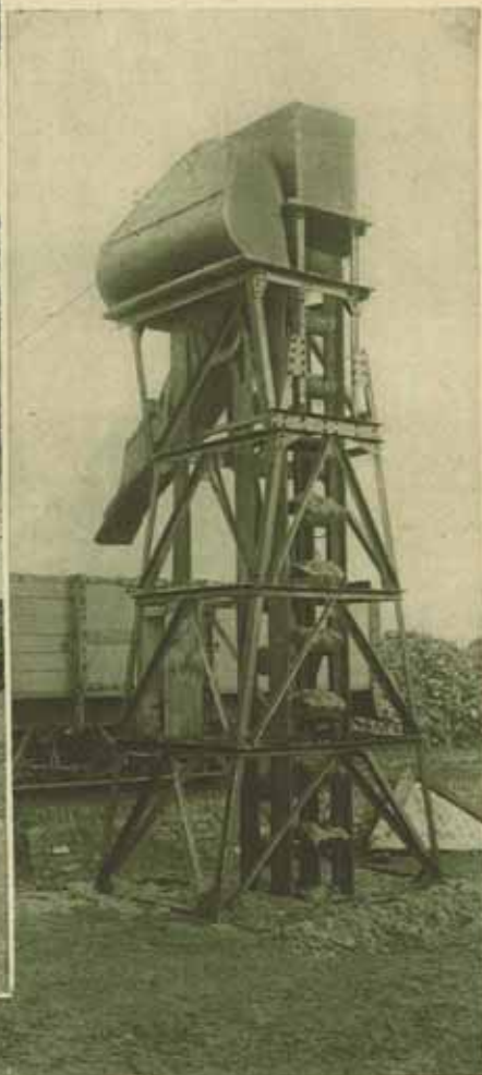
Elévateur vertical à pulpes pressées pour le chargement des wagons.
