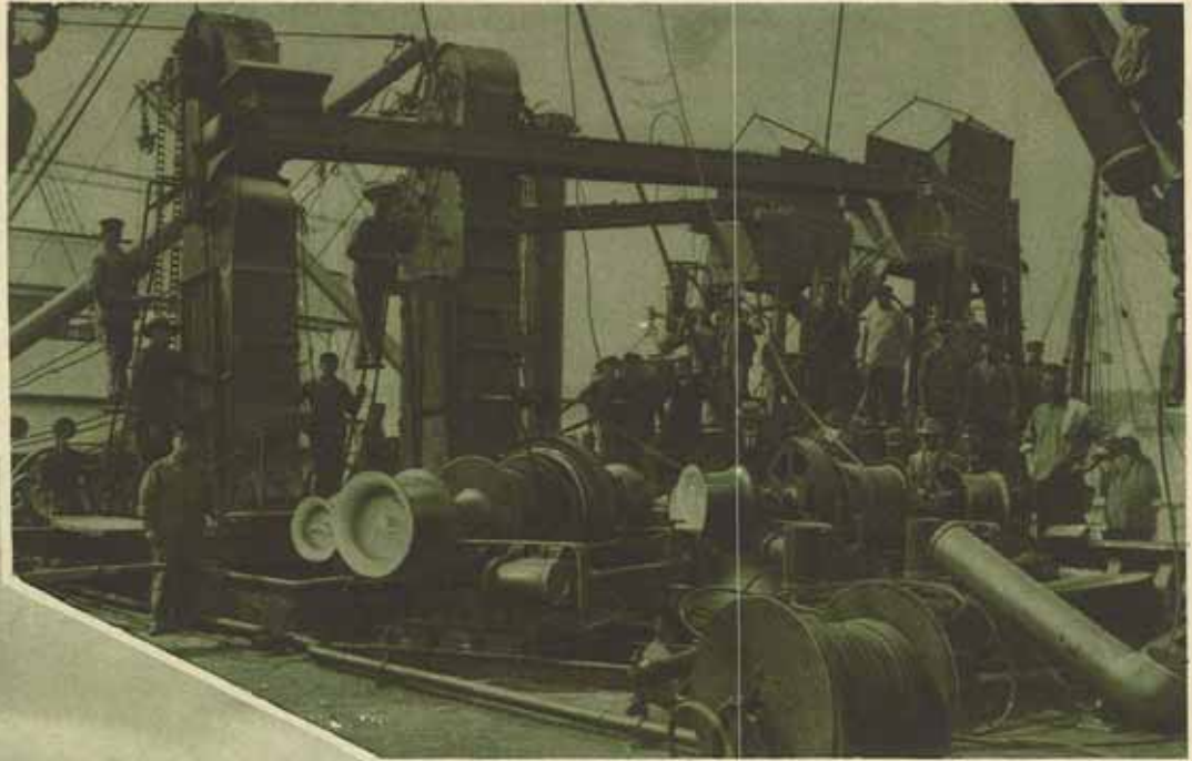
Elévateurs portatifs montés sur le bateau de grains à décharger.
