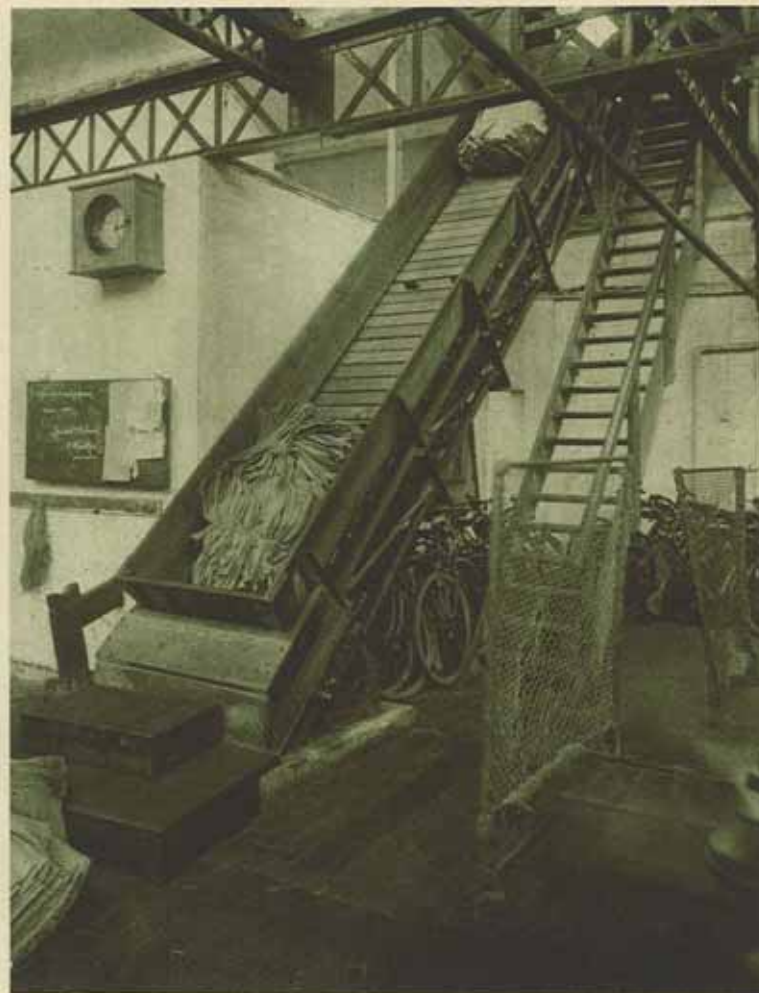
Transporteur à tablier roulant, partie inclinée et partie horizontale, pour ballots de tissus dans un atelier de tissage.
