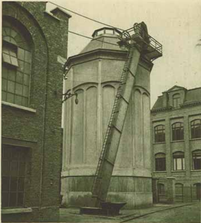
Elévateur à charbon, alimenté par distributeur à vis, et alimentant une vis de répartition dans un silo.
