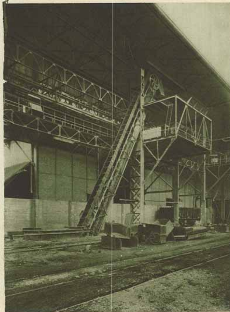
Elévateur incliné à godets continus pour scories brutes jusqu'à 400 m/m.
