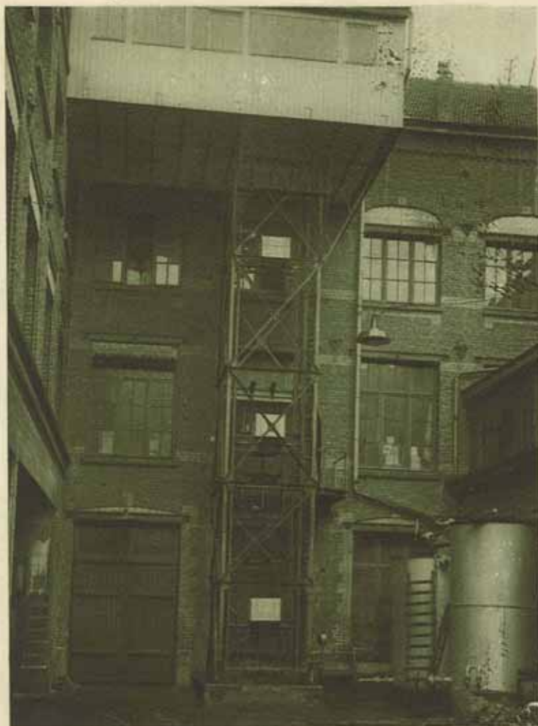
Elévateur vertical dit « Universel » pour matières premières en chocolaterie. Cet élévateur peut monter des caisses, des fûts, des sacs et des ballots jusqu'à 350 kg. par colis.
