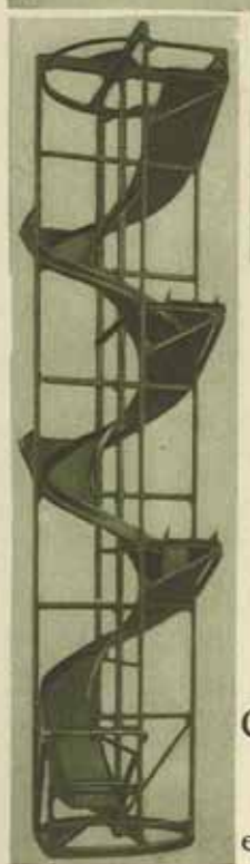
Descente en spirale par « Gravité ». Installation suspendue au plancher de l'étage supérieur.
