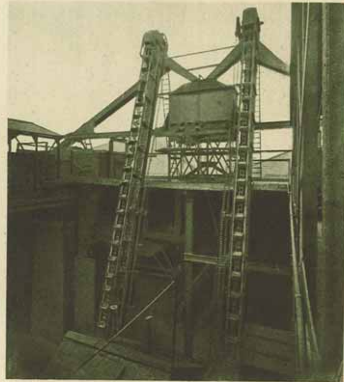
Elévateurs à charbon pour le remplissage d'une trémie ou le chargement de wagons.
