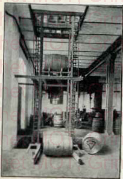
Elévateur vertical à fûts
