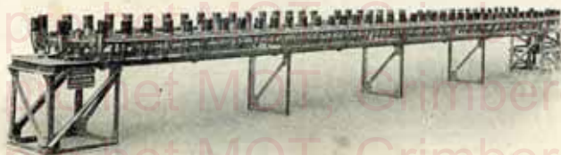
Transporteur égoutteur à bouteilles
