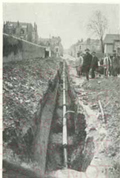
Fig. 37. Conduite en « ETERNIT » à la Ville de Tours. Diamètre 150 mm., pression d'exercice 5 atmosphères.
