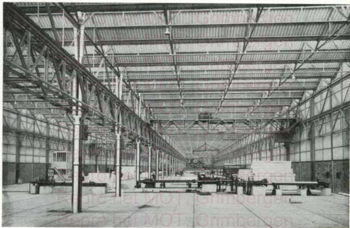
Société Anonyme « ETERNIT » : Division Tuyaux, Thisselt. Vue intérieure d'un des halls de fabrication.
