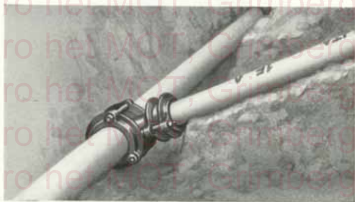
Fig. 15. — Dérivation sur joint « Gibault ».
