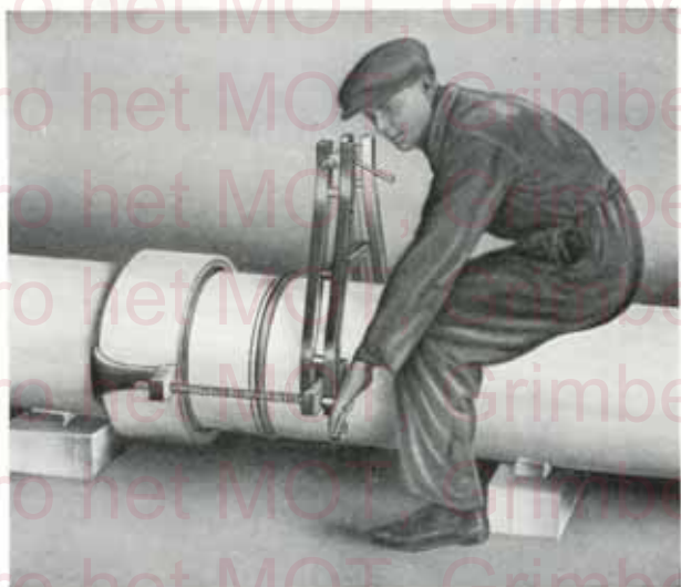
Fig. 4. — Mise en place du joint « Simplex ».
