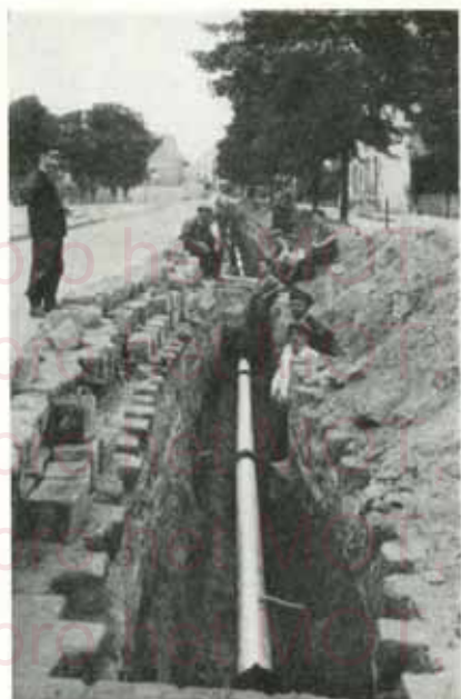
Fig. 34. Pose d'une canalisation en « ETERNIT » à Etampes. Diamètre 150 mm., pression d'exercice 5 atmosphères.
