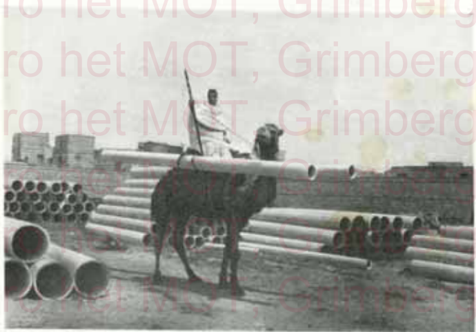
Fig. 42. — Tuyaux « ETERNIT » en Égypte. Transport de tuyaux.
