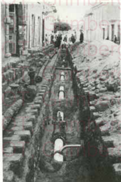
Fig. 34. Pose d'une canalisation en « ETERNIT » à Etampes. Diamètre 150 mm., pression d'exercice 5 atmosphères.
