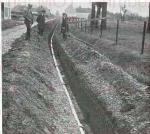
Fig. 27. — Conduites de gaz (6 km.) en tuyaux « ETERNIT » de 100 mm. aux Usines à gaz de Lessines.
