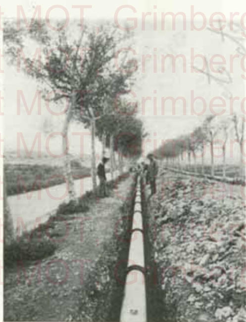
Fig. 37. Conduite en « ETERNIT » à la Ville de Tours. Diamètre 150 mm., pression d'exercice 5 atmosphères.
