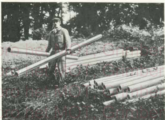
Fig. 32.— Manutention de tuyaux « ETERNIT » diamètre 100 mm., longueur 3 mètres.
