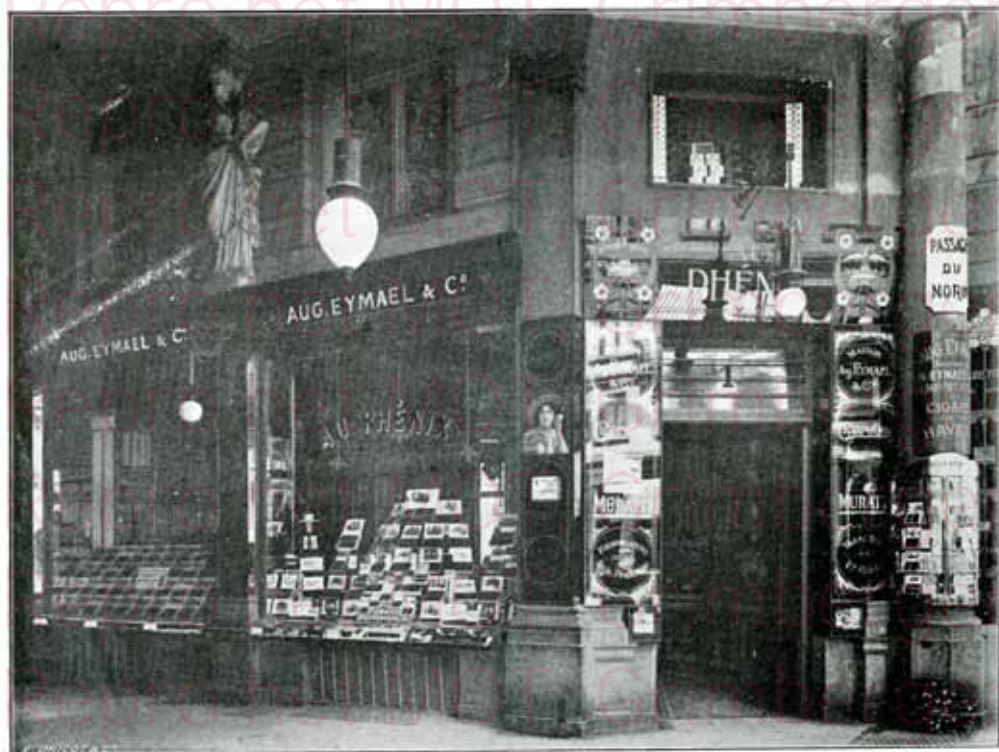
Vue extérieure des magasins Passage du Nord (côté du Passage)
