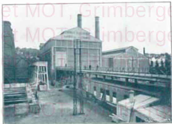
Centrale Electrique de Wasquehal (Nord, France)
