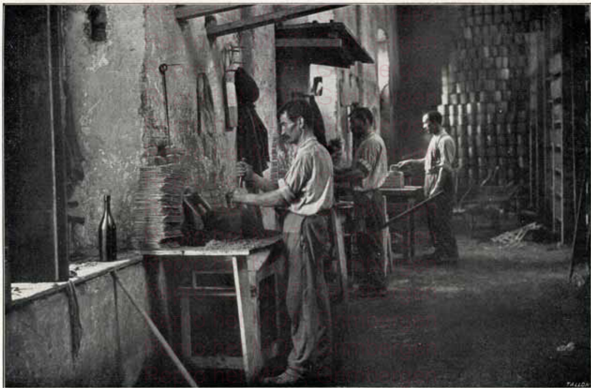
Fabrication des cylindres à notre usine, rue d'Amsterdam, 1.
