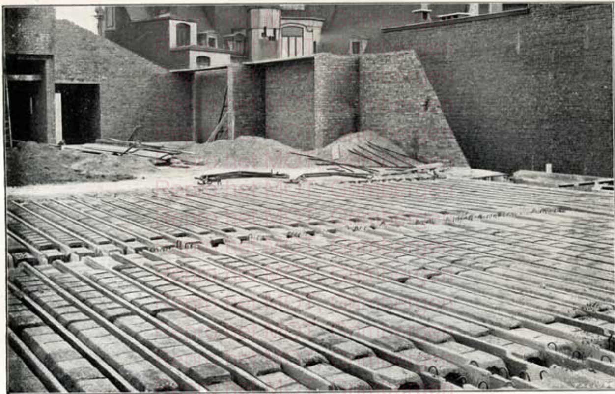
Garage de la rue de Jésus, à Anvers.
