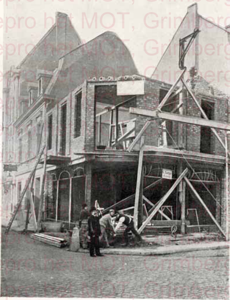
Comment on monte les poutres.
