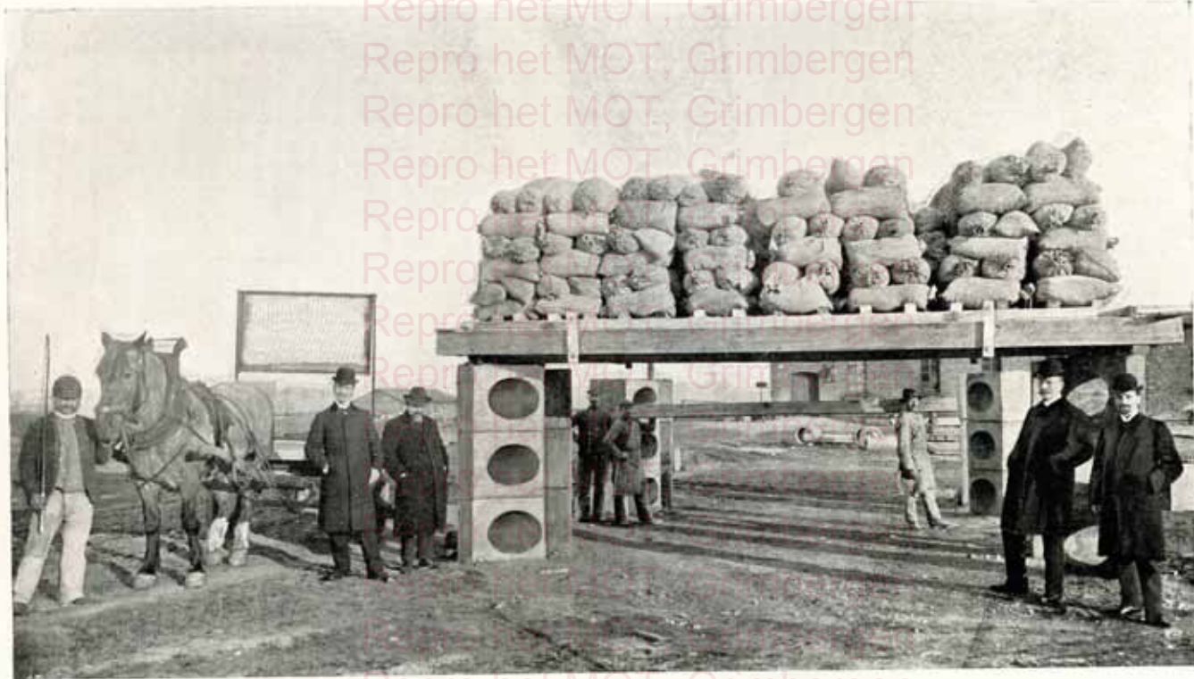
Essai d'un plancher de 9 m. 25 de portée. Avec une charge quintuple, aucune fissure ne s'est produite.
