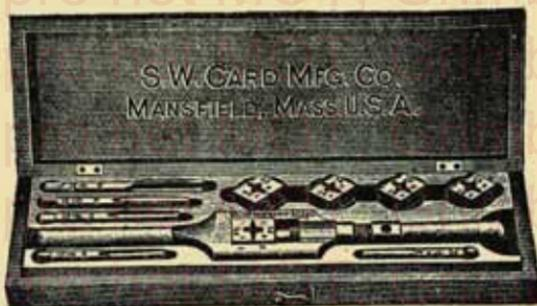
Outil de qualité extra supérieure. La cage de cette filière se transforme en tourne-à-gauche au moyen de faux coussinets. Le bras droit de la filière se visse sur l'extrémité de la cage et permet de serrer les coussinets à volonté. En boîte vernie très solide avec compartiment pour chaque pièce.
