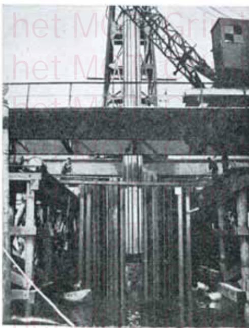
Fermeture du batardeau côté amont. — Pile B.
