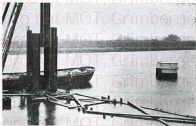
Battage d'une pile circulaire et vue d'un duc d'Albe achevé.
