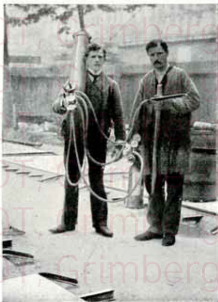
Transport d'un poste de soudure oxhydrique.
