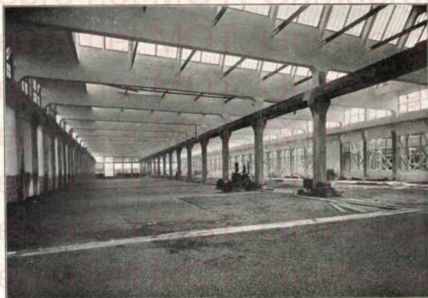
FIG. 27. — Toiture Shed portée par poutres Kahn de 21 m. portée, Usine à Buffalo E. U. d'A.
