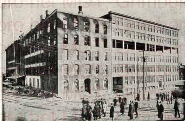
FIG. 26. — Après un incendie. — A droite une partie en béton armé, à gauche une partie en charpente (voûtelettes en béton entre poutrelles). La dernière fut tout à fait détruite, la première passa le feu sans dommages importants.
