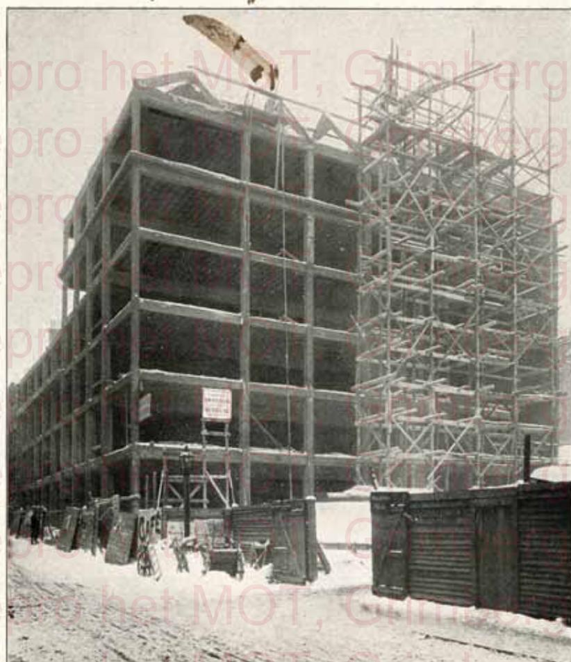
FIG. 24. — Maison de commerce à Stockholm (Suède), bâtie au milieu d'un hiver rigoureux,  $7,000 \text{ m}^2$  de planchers en 70 jours. Il y a des portées jusqu'à 13,3 m. à grande surcharge.
