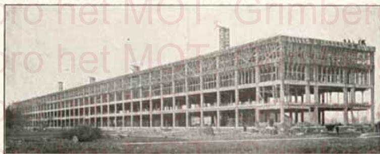
FIG. 25. — Fabrique en béton armé,  $2000 \text{ kg/m}^2$  surcharge construite en 60 jours,  $25 \times 250 \text{ m}$ . de longueur.
