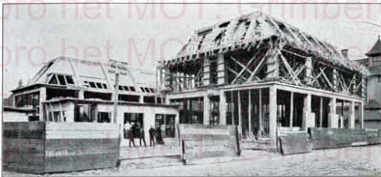
Fig. 36. — Pavillons d'hôpital de la ville d'Essen, en béton armé, système Kahn.
