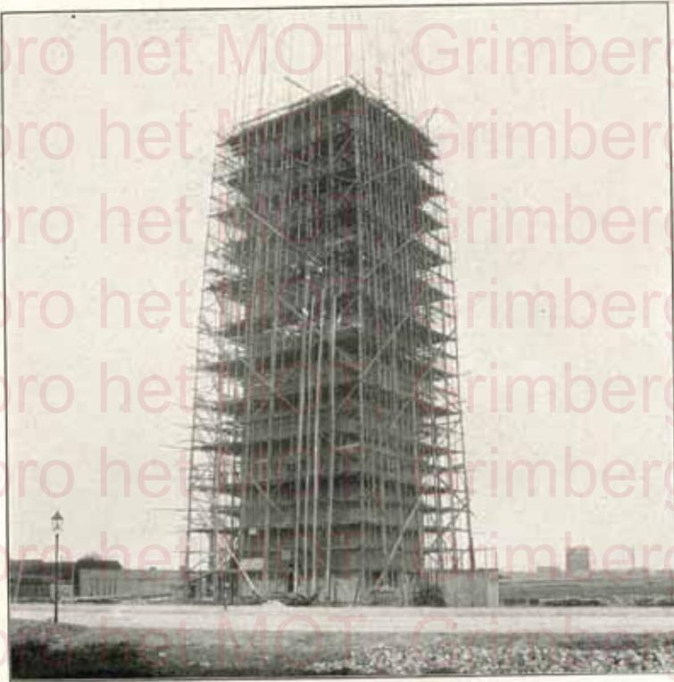
FIG. 37. — Château d'eau à Berlin, 80 m. de haut, capacité 1000 m<sup>3</sup>, portées 12,0 m. en béton armé, système Kahn.
