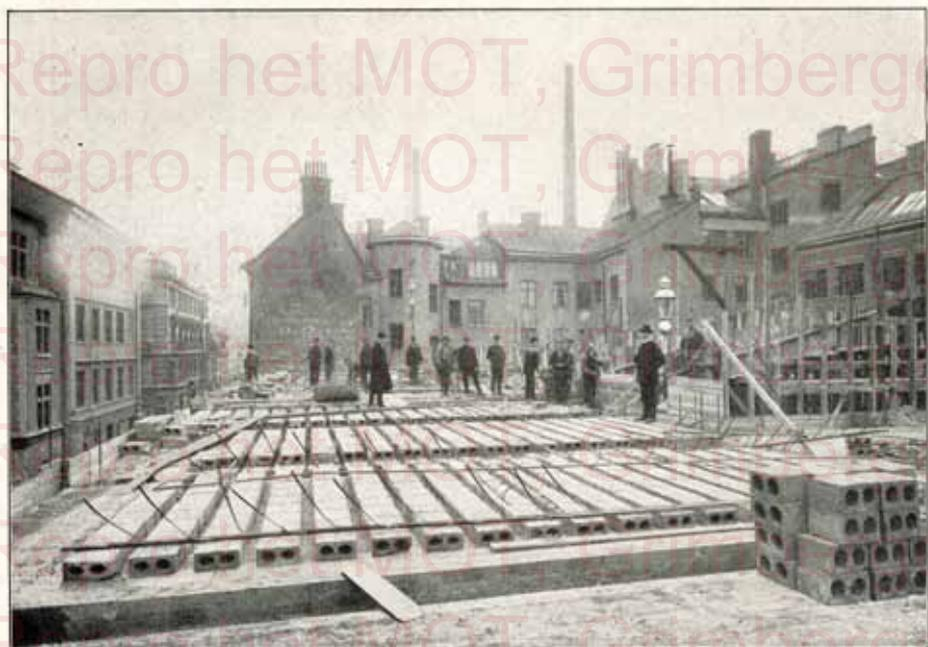
FIG. 22. — Construction d'un plancher creux, à Stockholm.
