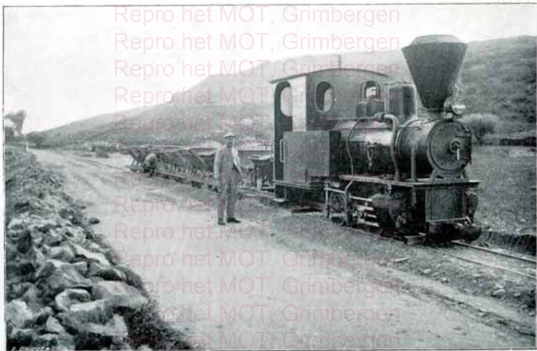
TRAIN DE BALLAST (CONSTRUCTION DE LA VOIE)
