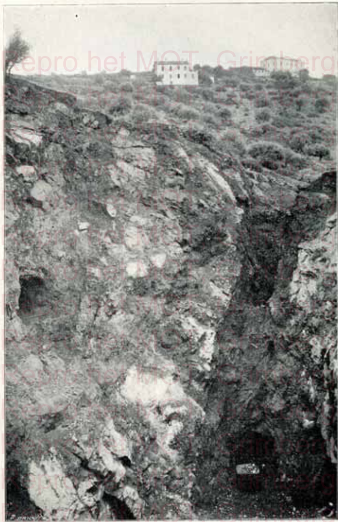
TRANCHÉE MS N°3 MAISONS DU DIRECTEUR ET DU SOUS-DIRECTEUR
