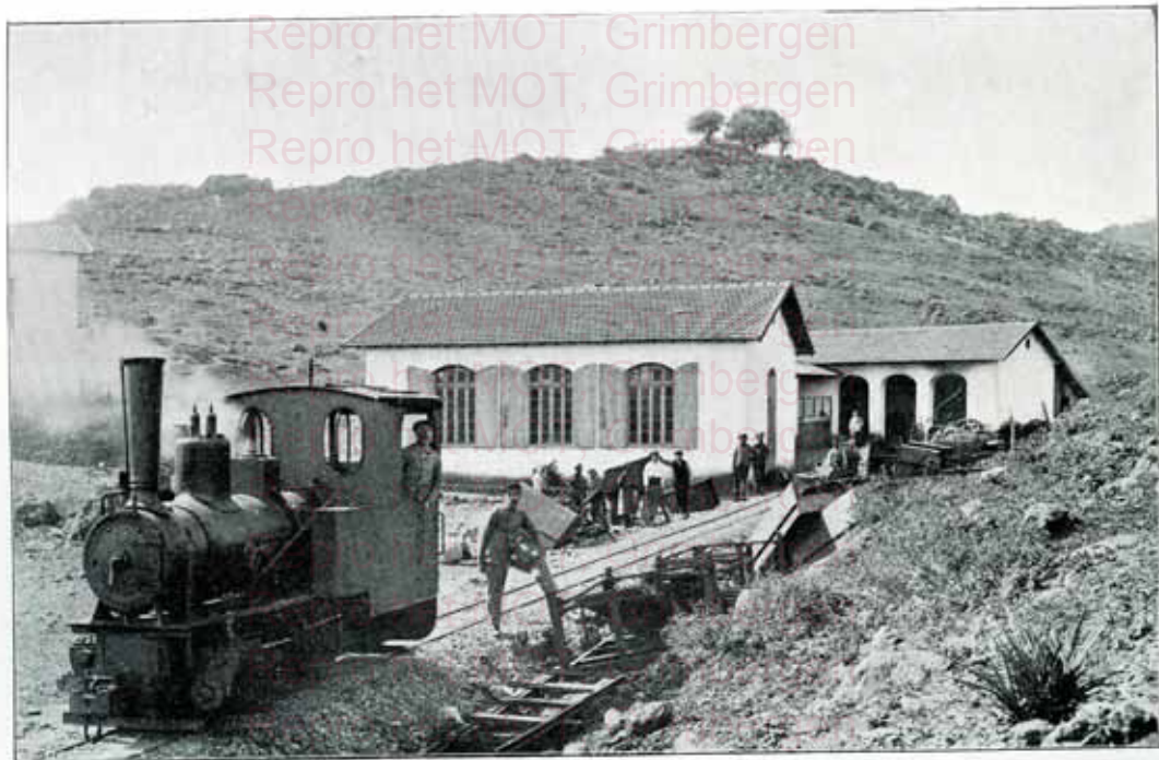
ATELIERS ET REMISE DE LOCOMOTIVES
