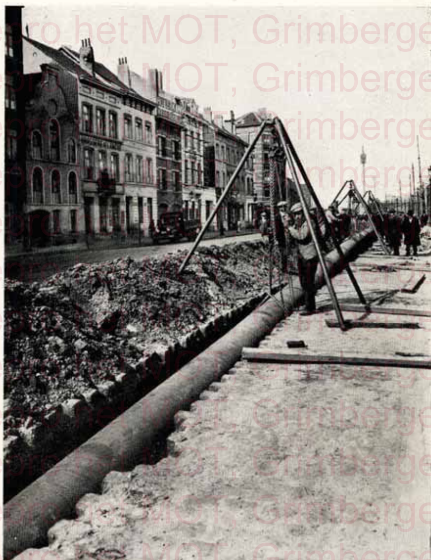
Descente en tranchée d'une très longue colonne assemblée hors sol. A remarquer le personnel réduit et la simplicité de cette opération.
