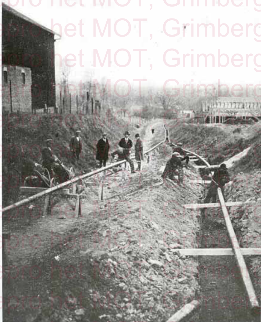
Tronçons assemblés hors tranchée.
