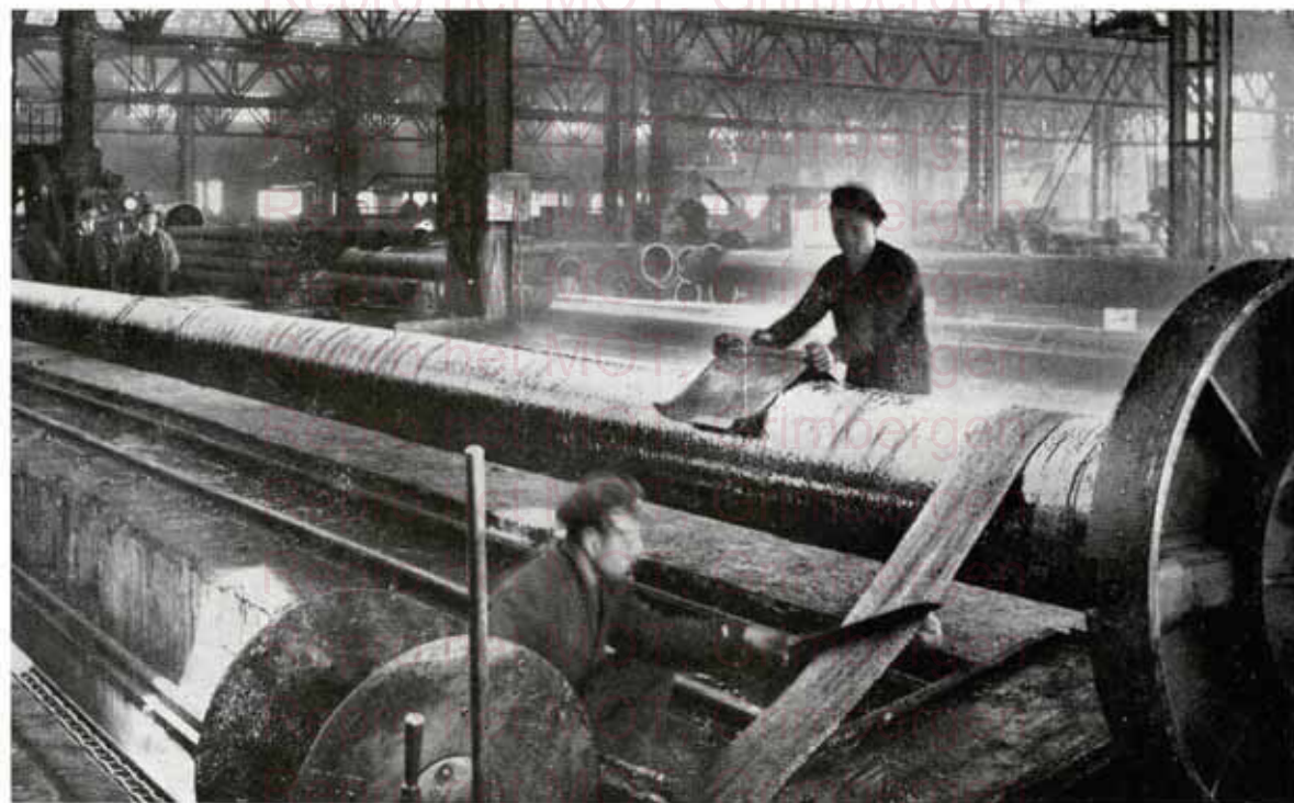
Recouvrement des tubes de l'enveloppe protectrice extérieure.
