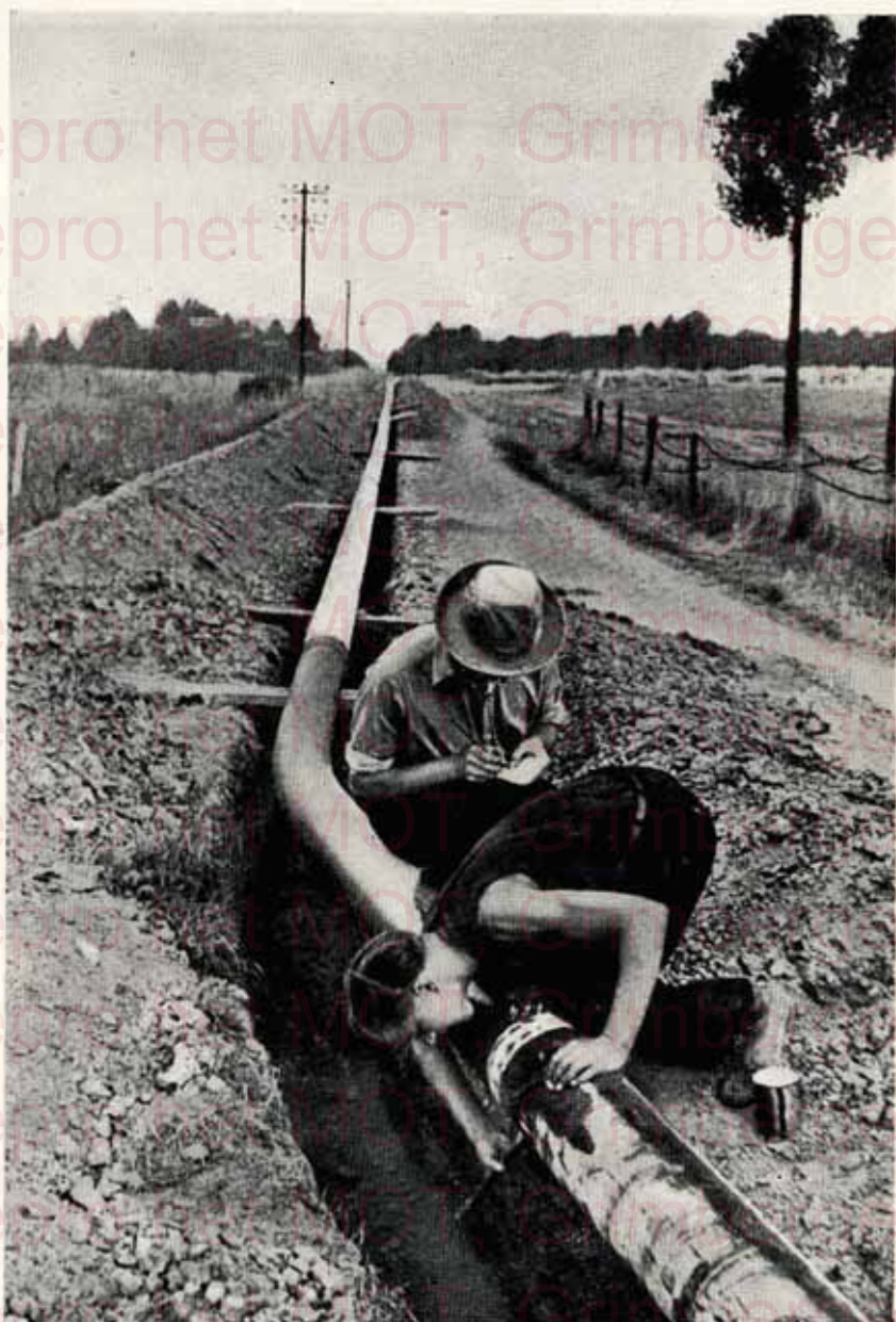
Protection d'un joint avant descente d'une canalisation dans la tranchée.
