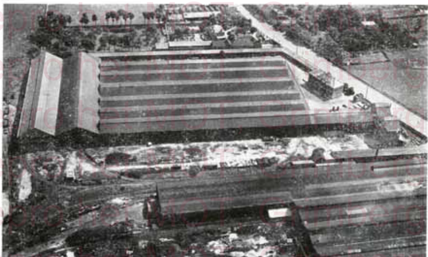
Vue des Usines de Jemappes. Division des tubes de petits diamètres et de faibles épaisseurs soudés à l'électricité.
