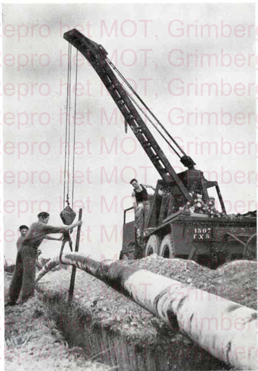
Cette photo montre la forte élasticité et la grande flexibilité des tubes en acier.
