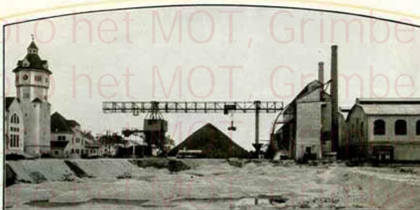
Transbordeur de déchargement à commande électrique dans une usine à gaz.
