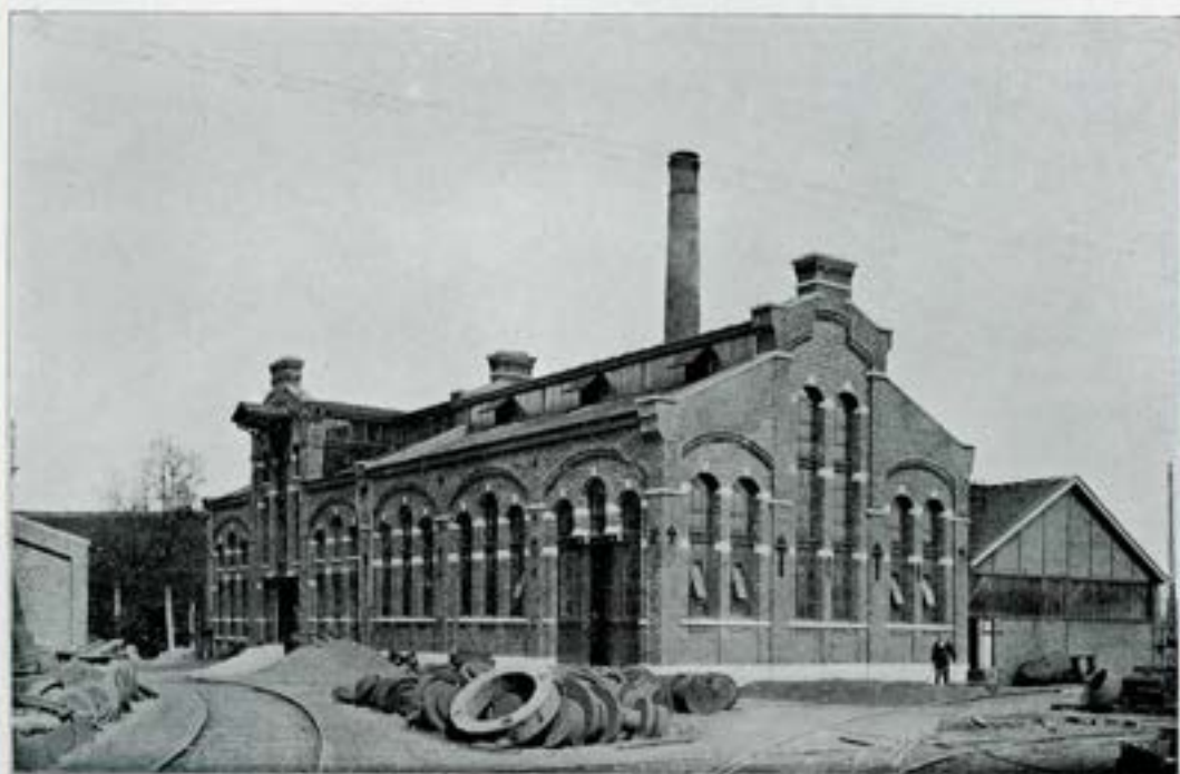
LES SALLES DES MACHINES ET CHAUDIÈRES
