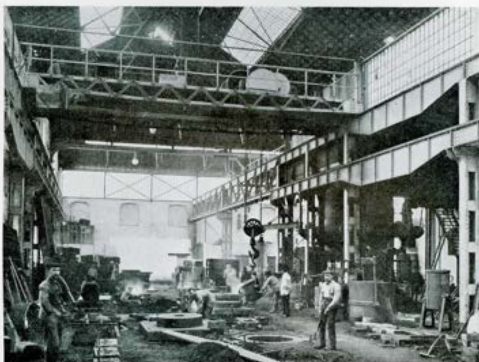
VUE INTÉRIEURE DE NOTRE Fonderie.
