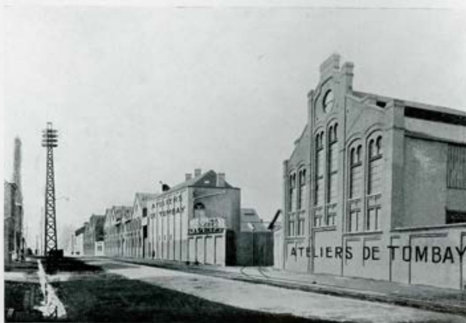
VUE GÉNÉRALE DE L'USINE
