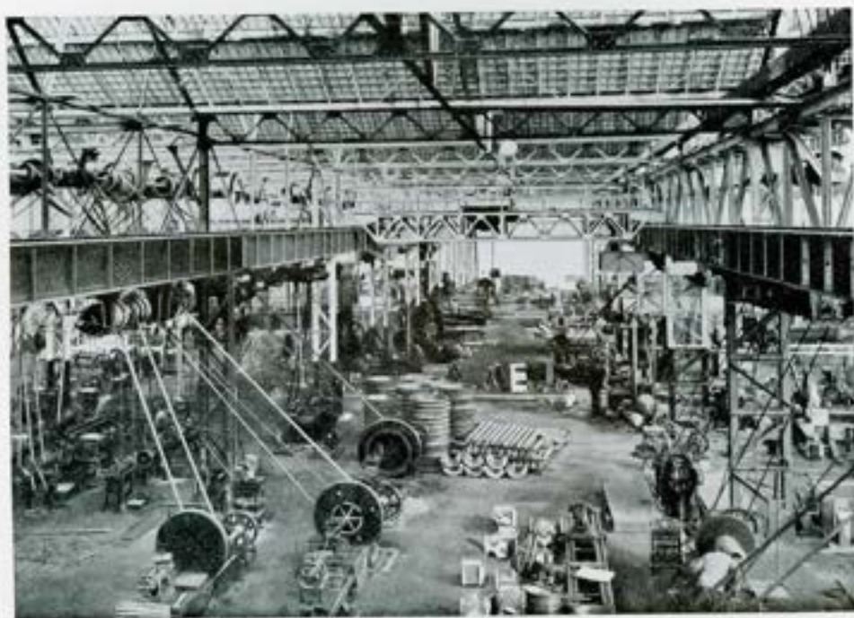
VUE INTÉRIEURE DES ATELIERS DE MÉCANIQUE
